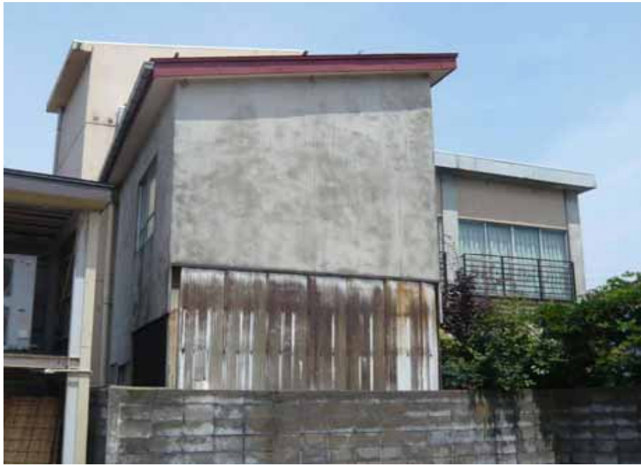
ラスシートモルタル被害なし
