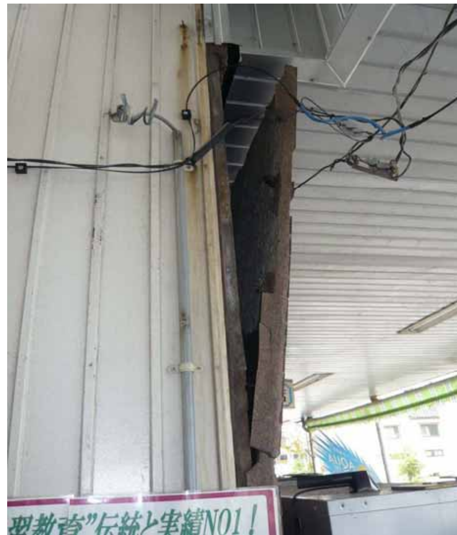
木毛板下地材ごとモルタル部分剥離
