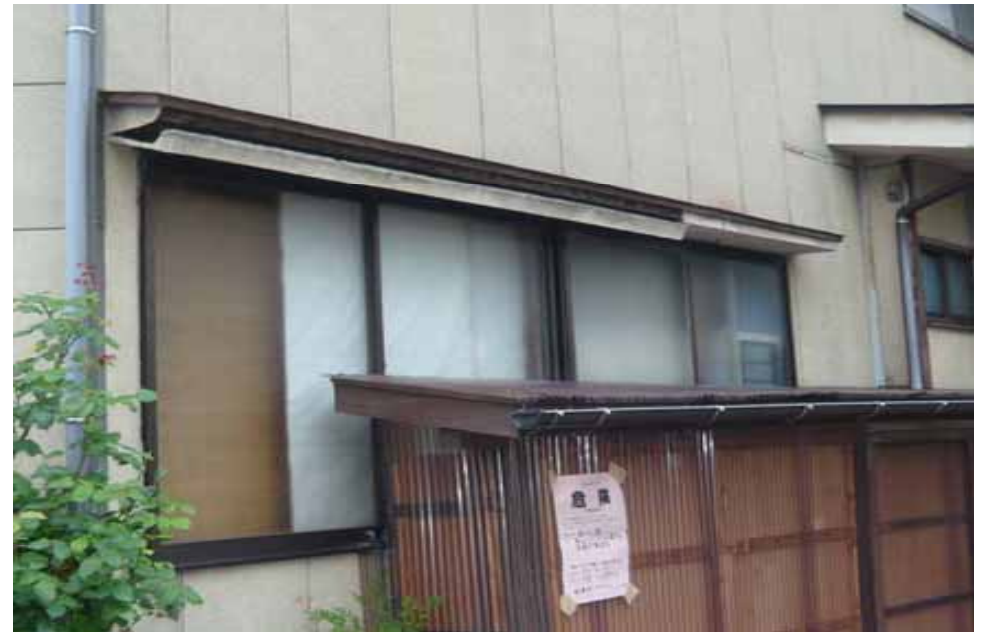
軒部分のみラスモルタル(危険判定)
