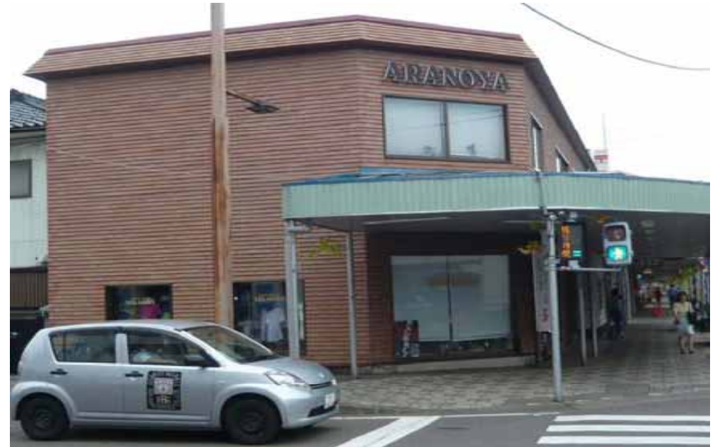
乾式タイル張り(釘止め)被害なし
