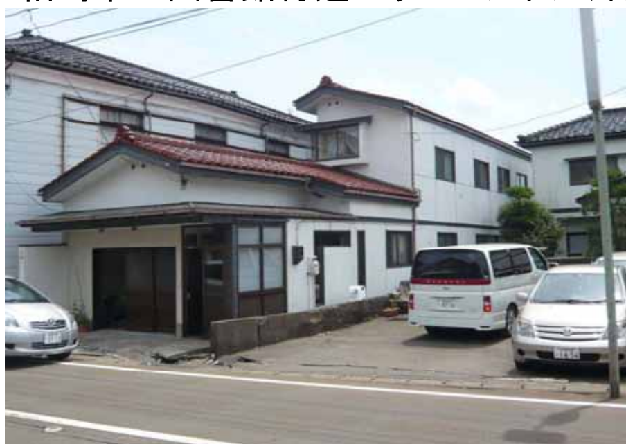
外壁の被害なし。
