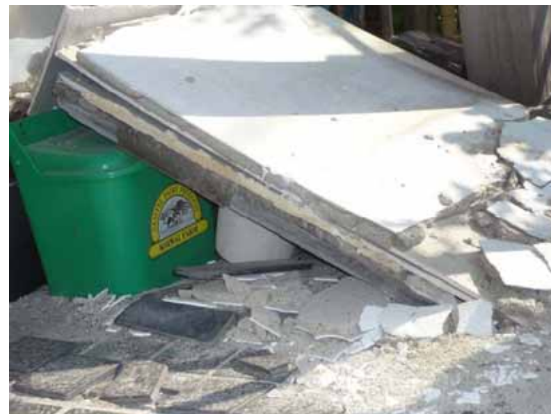
基礎部分ラスモルタルタイル張り脱落
