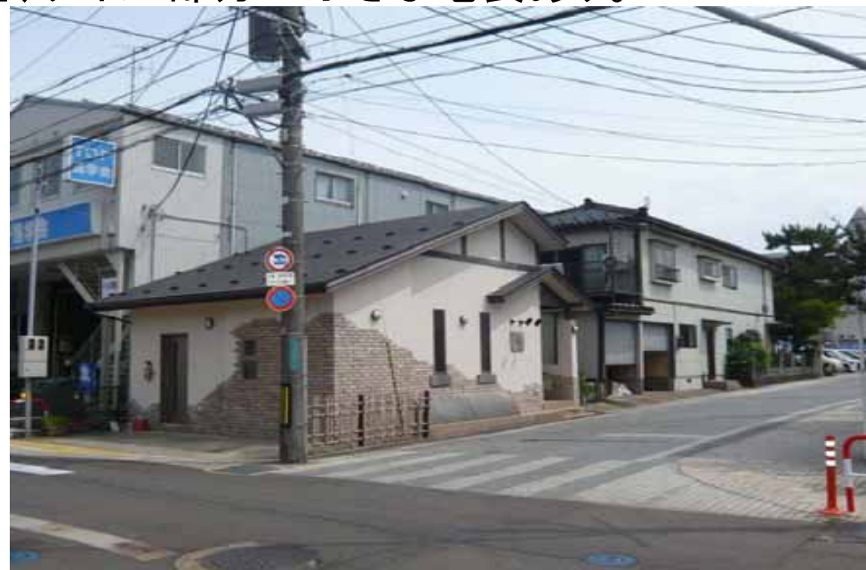
最近の建物でラスモルタルにブリックタイル張り被害なし
