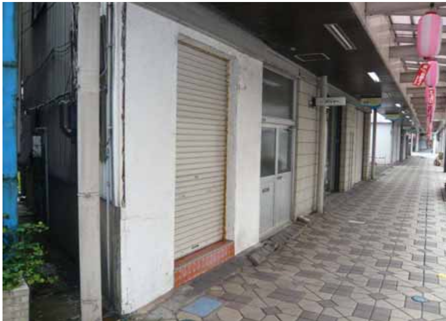
駅前商店街・部分クラック(地震前の物)
