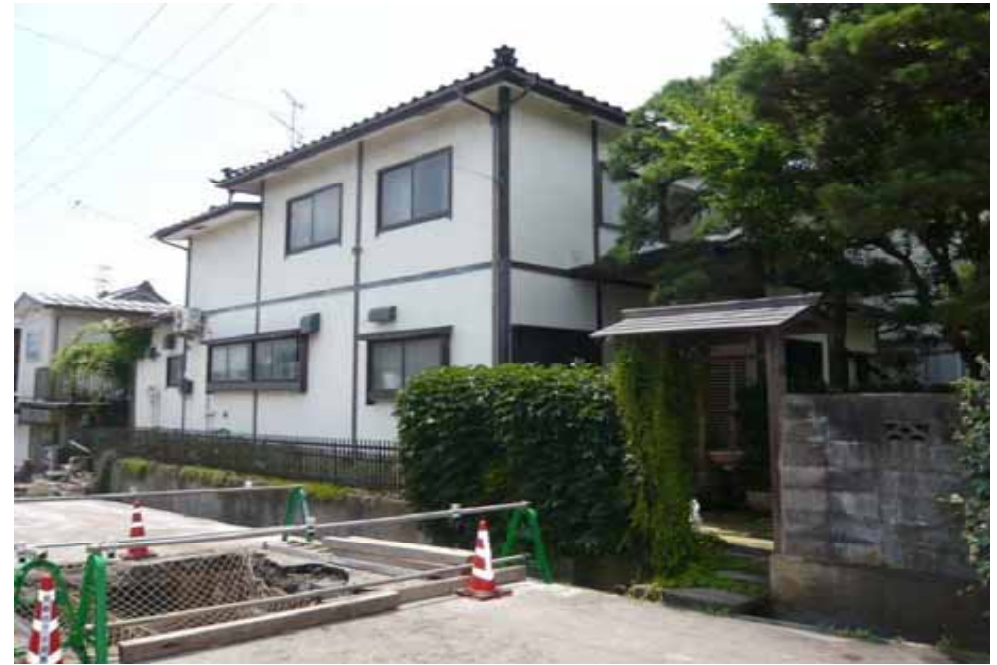
ラスモルタル外壁(真壁)、外壁の被害なし
