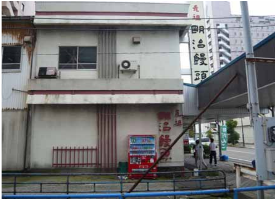
鉄骨ラスシートモルタル被害なし
