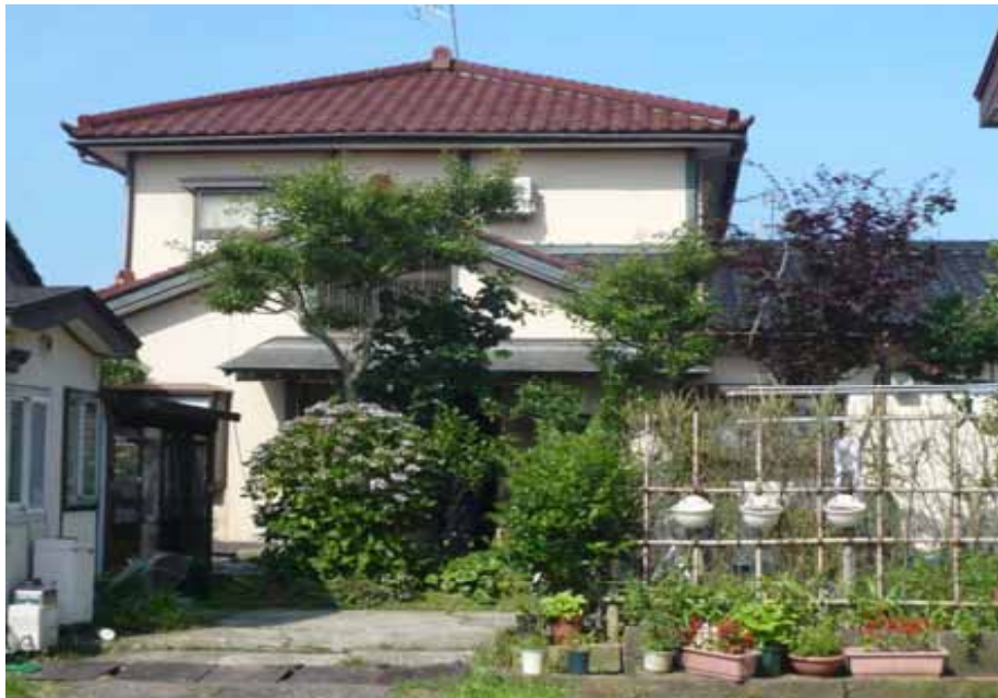
木造ラスモルタル外壁被害なし
