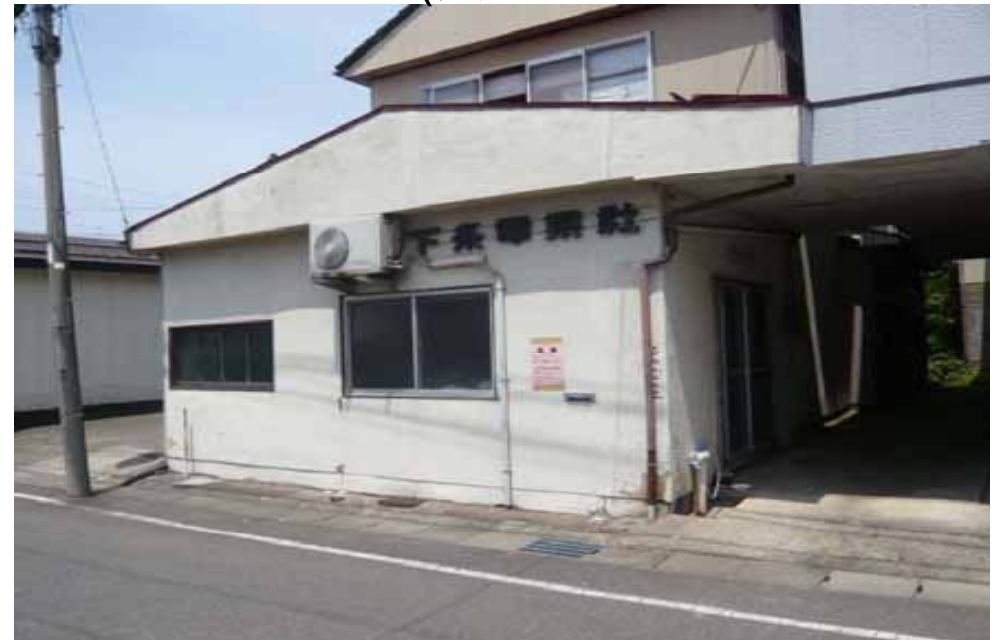
木造ラスモルタル外壁被害なし
