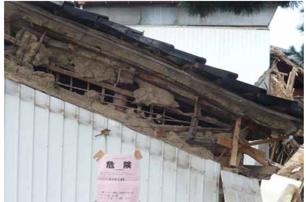
倒壊した木造瓦拭き屋根の部分
