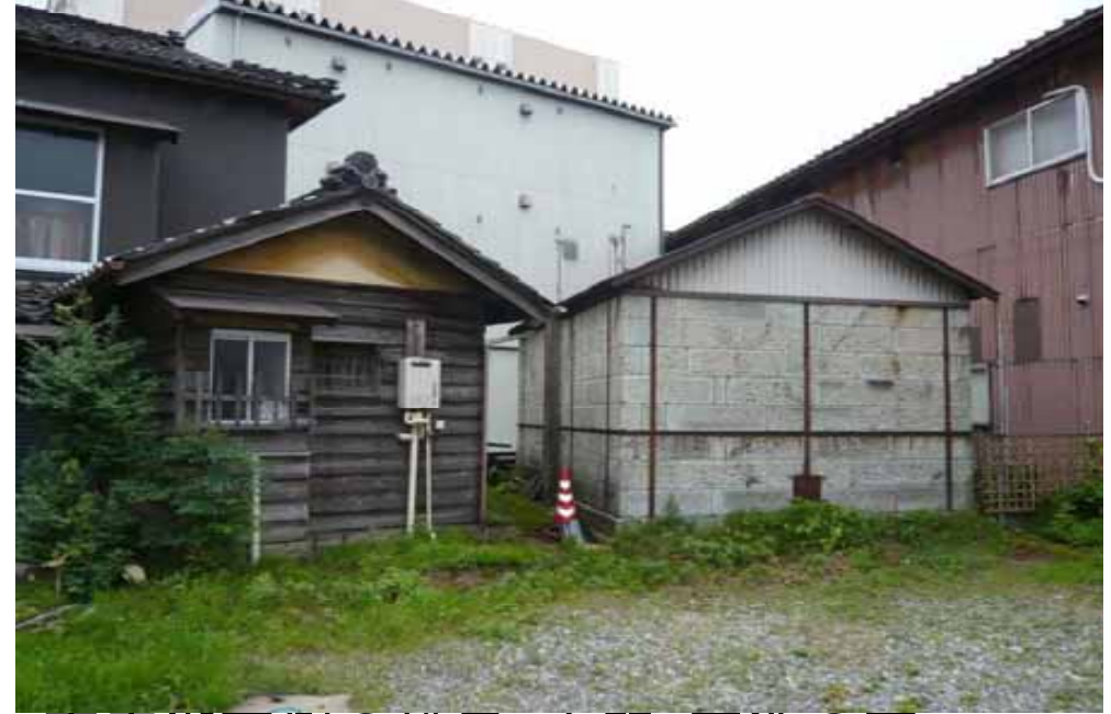
商店街裏側の様子・土壁・石造の蔵
