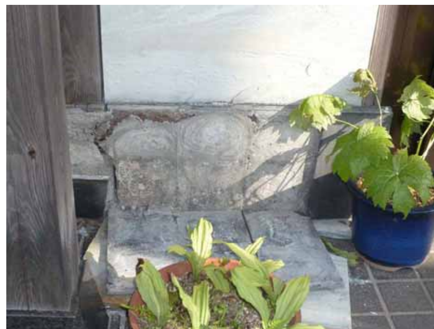
基礎部分ラスモルタルタイル張り脱落
