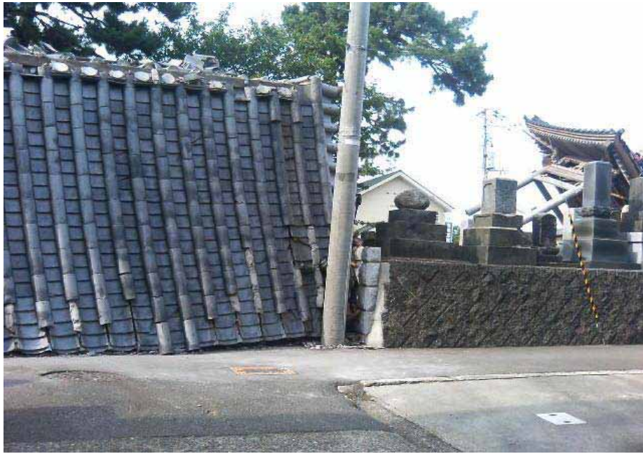
倒壊したお寺の山門・鐘突き堂
