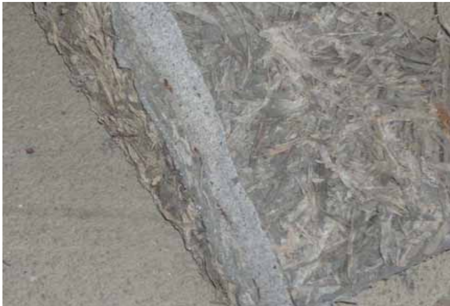
木毛板へのラス固定不良
