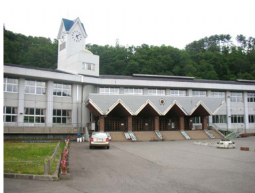
写真17 同小学校正面
