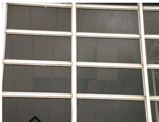
写真19 体育館天井パネルの様子
