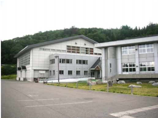
写真16 山内小学校体育館
