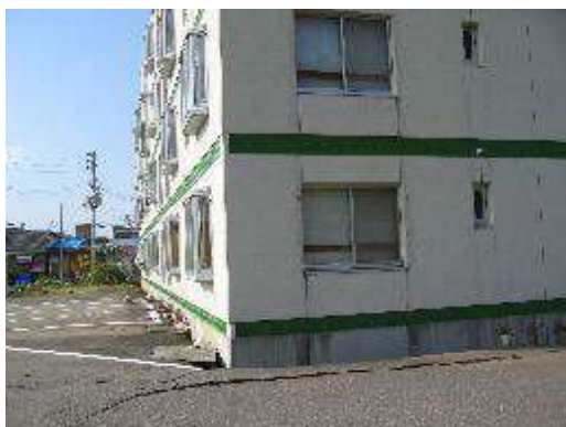
図 5-2-6 建物基礎の沈下被害
