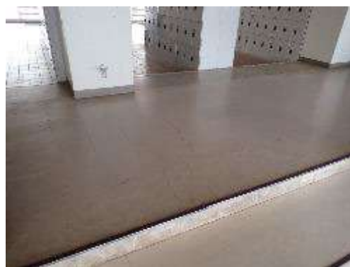
図 5-2-11 側方流動による1階床ひび割れ
