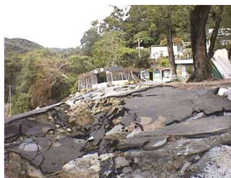
図 2-15 1999 年台湾集集地震の際、台中市軍功小学校の断層ずれによる上盤側の地盤変状（撮影：久田）
