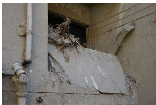
面外破壊した鉄筋コンクリート造片持ち壁
