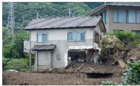
2021 年熱海市の土石流で被災した新しい木造住宅（1 階隅角部が土砂・瓦礫で削り取られた）
