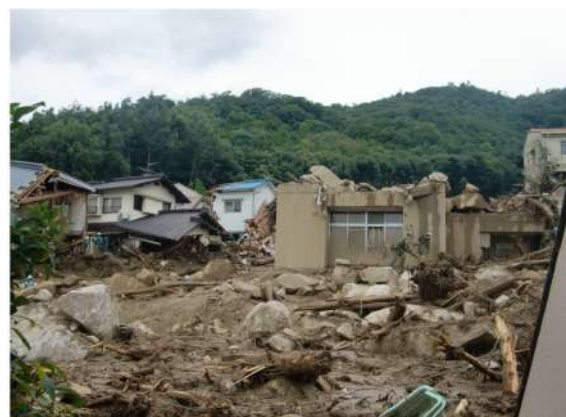
面外破壊した鉄筋コンクリート造パラペット
