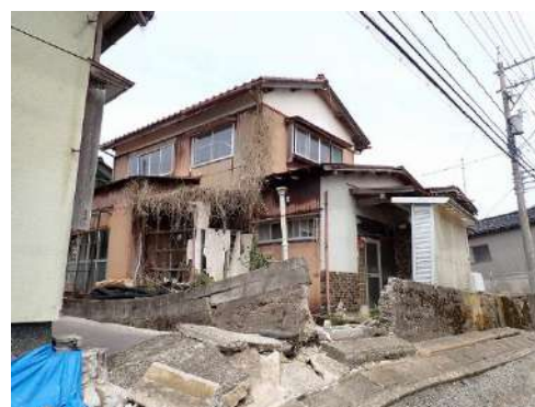
図 2-12 液状化による岸壁・護岸の背後地盤や傾斜地盤での側方流動 2-9)
