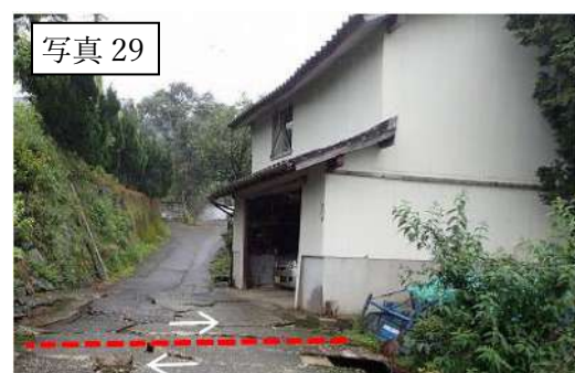
図 4-6-4 図 4.6-2 で示した位置の写真 28（断層ずれに伴う地盤変状で生じた敷地と古い木造住宅の基礎の亀裂）、写真 29（横ずれ断層が貫通し、大きくねじれ変形が生じている木造の車庫・倉庫） 4-5)
