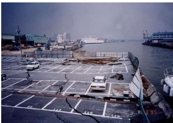
護岸の孕み出しと背後地盤の亀裂（撮影：安田） 岸壁背後地盤の側方流動変位分測定例 5-9)
