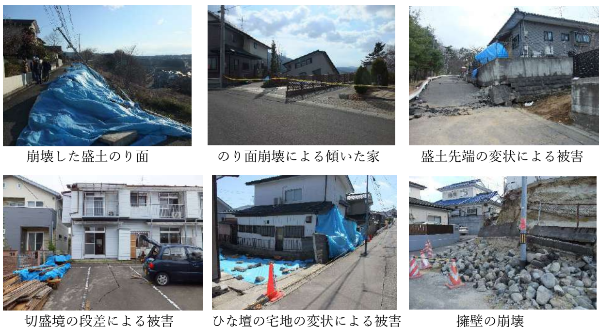
図 2-11 のり面の崩壊、切盛境の段差、宅盤の変状、擁壁の崩壊による典型的な被害（撮影：安田）
