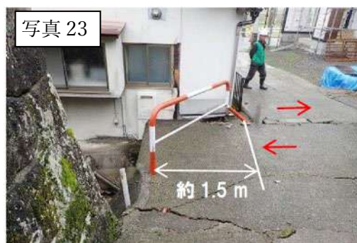
図 4-6-3 図 4.6-2 で示した位置の写真 23（地表地震断層の位置と横ずれ変位の大きさ）と写真 24（断層位置と基礎が破壊され、壁が傾斜した旧耐震の木造住宅） 4-5)
