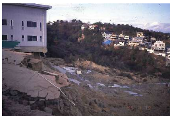
図 2-7 1995 年兵庫県南部地震による西宮市仁川の盛土造成地の被害（撮影：安田）
