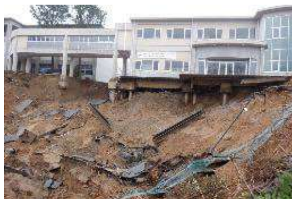
図 5-2-7 基礎周辺盛土の大規模崩落(基礎損傷なし)
