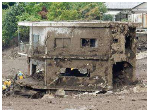
図 5-3-1 土石流の例（熱海市の土石流で被災した3階建てRC造建物：1階は土砂に埋没し、2・3階の上流側の非構造壁は破壊されているが、構造躯体は健全であり、下流側の3階の部屋や屋上には生存空間がある；撮影・久田）
