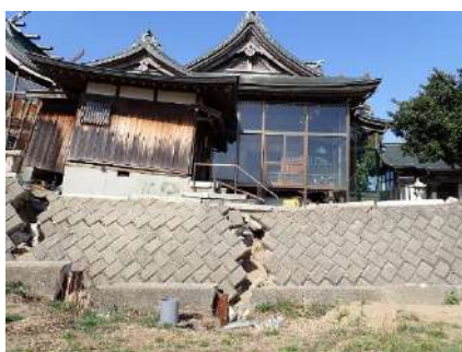
2024 年能登半島地震のかほく市大崎での側方流動による擁壁と建物の被害
