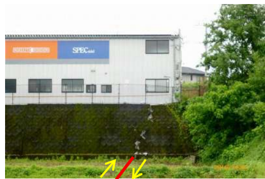
図 5-4-2 盛土上の建物の被害例（2016 年熊本地震で被災した盛土上の S 造建物：断層ずれは盛土内で低減し、建物は軽微な被害であった。但し、盛土の擁壁には亀裂が生じている；撮影・久田）
