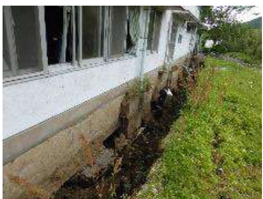
図 5-2-8 基礎周辺がけ地側方流動に伴う傾斜
