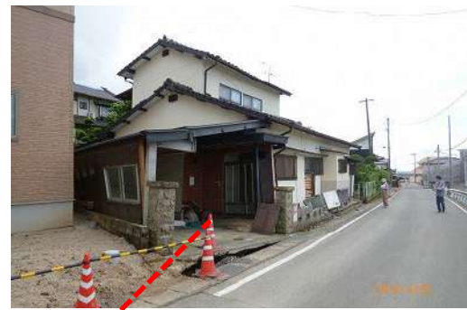
図 4-6-3 図 4.6-2 で示した位置の写真 23（地表地震断層の位置と横ずれ変位の大きさ）と写真 24（断層位置と基礎が破壊され、壁が傾斜した旧耐震の木造住宅） 4-5)
