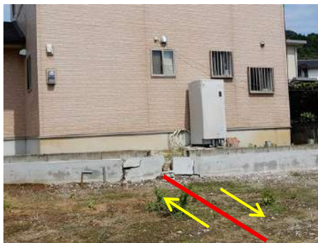
図 5-4-1 横ずれ断層変位の上の建物例（2016 年熊本地震による断層ずれで手前の塀は破壊されたが、2000 年耐震基準によるべた基礎上の木造住宅は無被害であった（撮影・久田）
