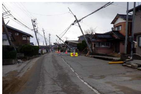
能代で発生した緩やかな傾斜地盤の流動 5-10 地盤の流動で生じた盛上り（撮影：安田） 図 5-5-5 液状化にともなう緩やかな傾斜地盤の流動による被害
