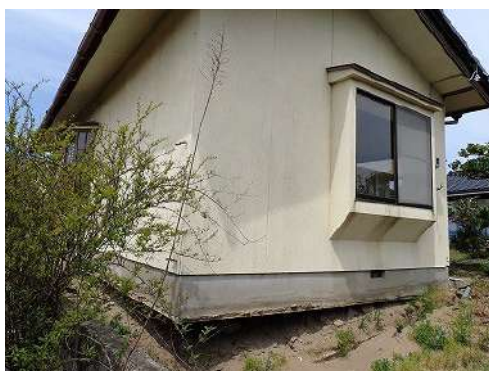
図 5-5-1 側方流動による建物の被害例（2024年能登半島地震で被災した木造住宅：敷地の砂地盤が流動し、基礎下が空洞化している。基礎はRC布基礎であり、大きな被害は逃れている：撮影・久田）
