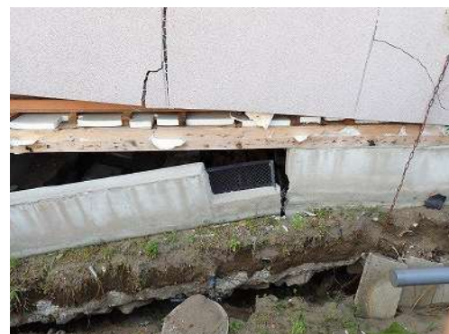
図 5-5-2 側方流動による建物の被害例（2024年能登半島地震で被災した木造住宅：敷地の砂地盤が流動により、無筋の基礎が破断し、上部構造も大破している：撮影・久田）
