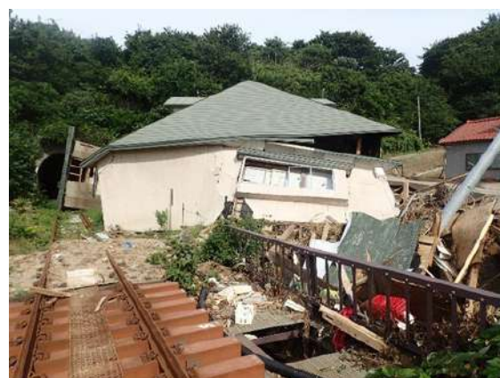
図 5-2-3 土砂災害による木造家屋の滑動
