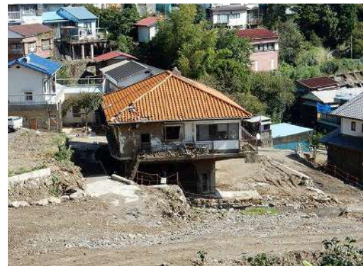
図 5-3-2 土石流の例（熱海市の土石流で被災した1階RC造、2階木造の混構造の住宅：1階に土砂が流入し、2階上流側には土砂の流入が見られるが、倒壊は逃れており、2階の下流側には生存空間がある；撮影・久田）
