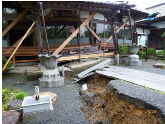
2011年福島県浜通り地震の古い寺院本堂 (縦ずれ変位で躯体が変形しているが、 「ねばり」で倒壊は逃れている)
