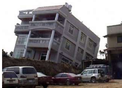
1999 年台湾集集地震の地表地震断層の直上の RC 造建物の傾斜被害（後に修復した）
