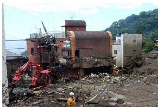
図 2-8 2021 年熱海市伊豆山地区上流の盛土崩壊による土石流による被害（撮影：久田）
