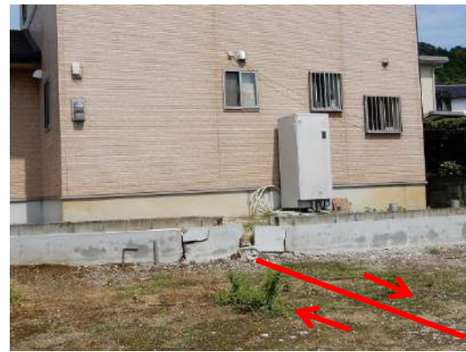
2016年熊本地震の2000年基準の木造住宅 (横ずれ断層でブロック塀を破壊している が、「強さ」で基礎や躯体は無被害)
