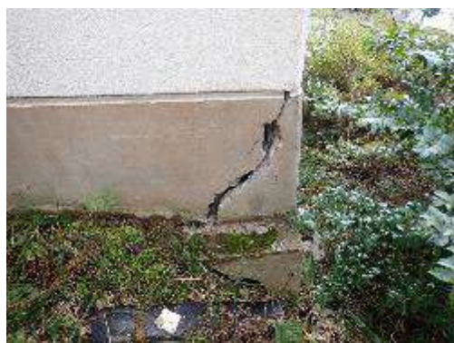
図 5-2-10 側方流動による基礎割れ被害
