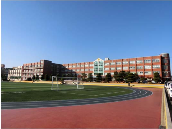
写真 15 H 中学校の教室棟の全景
