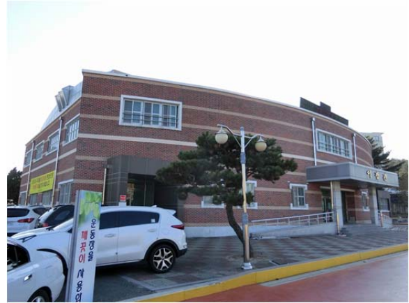
写真 16 屋内運動場の全景
