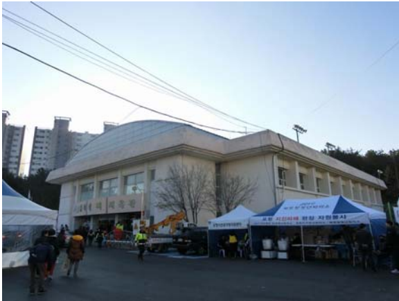
写真 39 避難建物となった H 屋内体育館の全景
