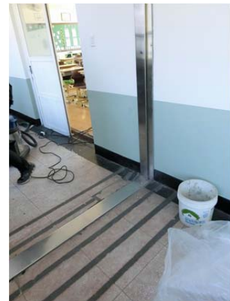
写真 14 EXPJ の損傷
