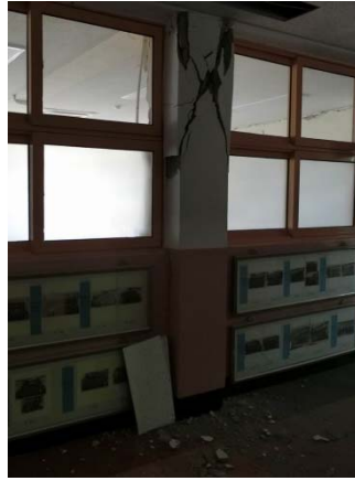
写真6 組積造袖壁と組積造腰壁を有している柱の損傷
