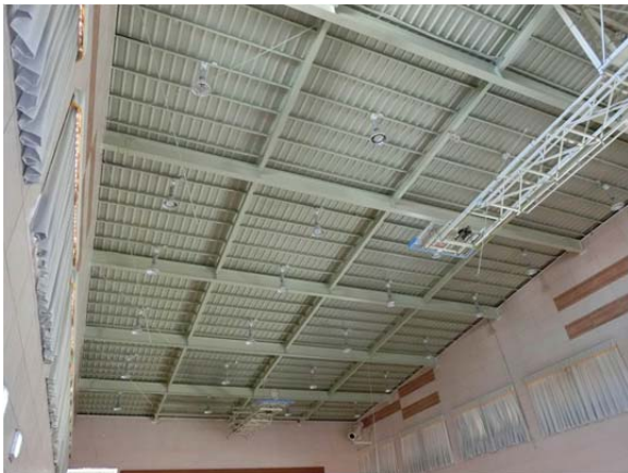
写真 21 屋内運動場の屋根ブレースの損傷状況と落下したブレース材
