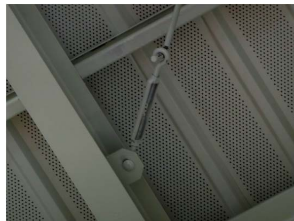
写真 22 ブレースの穴にかけるだけの施工
