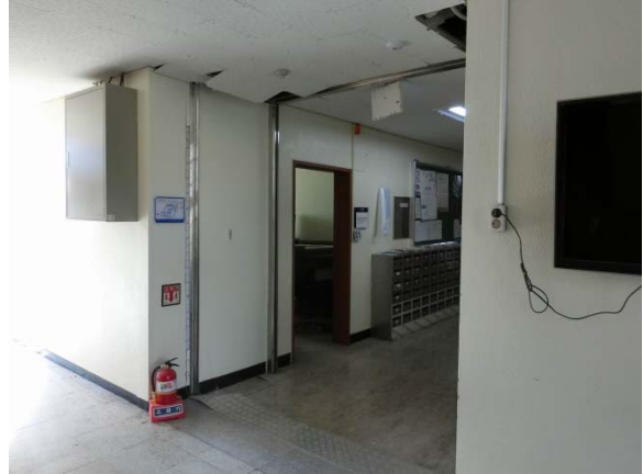
写真 25 EXPJ の被害
