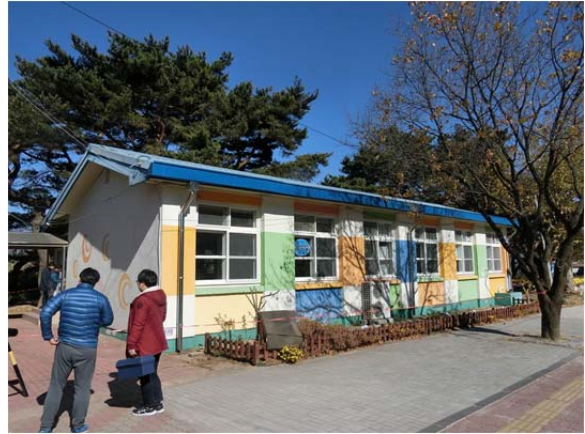
写真 27 給食棟の全景
