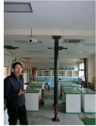
写真7 軸崩壊防止サポート設置工事
