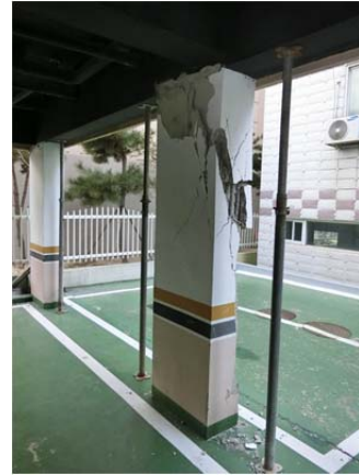
写真 34 B 集合住宅の 1 階柱の損傷（損傷度 V）
