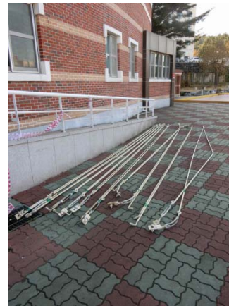
写真 17 屋内運動場の屋根ブレースの撤去作業の様子と撤去された曲がったブレース材
