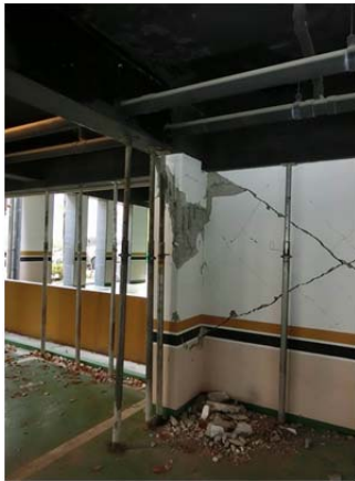
写真 35 壁の損傷（損傷度：III）とせん断補強筋の錆の様子
