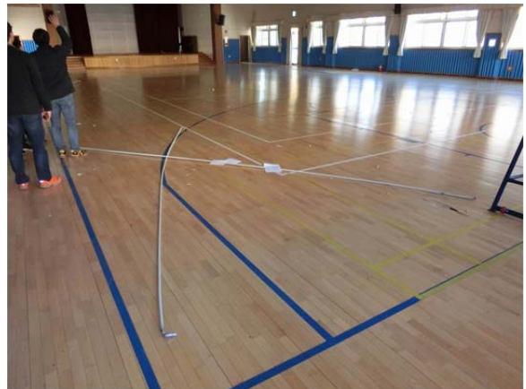
写真 21 屋内運動場の屋根ブレースの損傷状況と落下したブレース材
