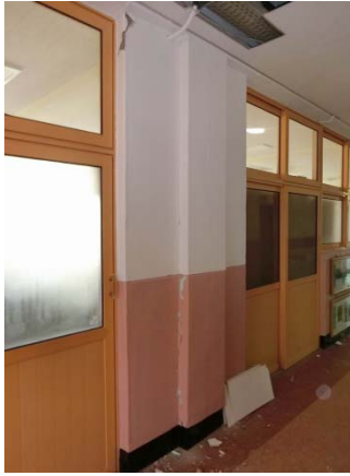
写真6 組積造袖壁と組積造腰壁を有している柱の損傷
