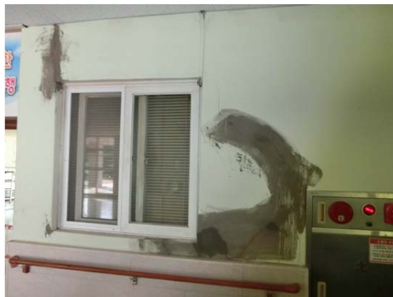
写真 18 外側組積造仕上げ材と建物内部のひび割れ発生個所に補修作業施工の様子
