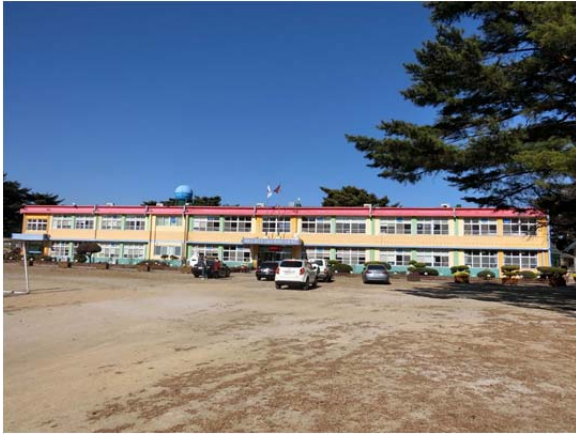
写真 26 H 西部小学校の教室棟の全景
