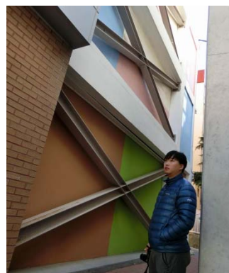
写真9 建物Cの耐震補強の様子とアンカーの損傷
