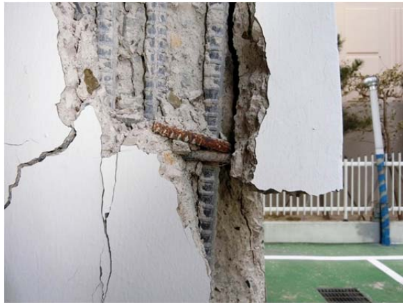
写真 35 壁の損傷（損傷度：III）とせん断補強筋の錆の様子
