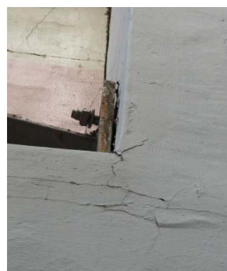
写真9 建物Cの耐震補強の様子とアンカーの損傷
