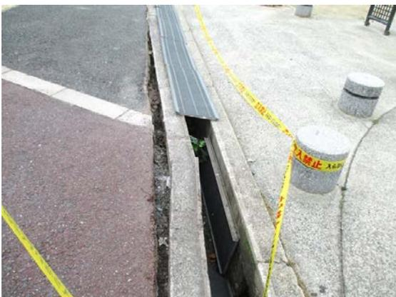
図 25 筒井池公園東側入口の側溝の被害
