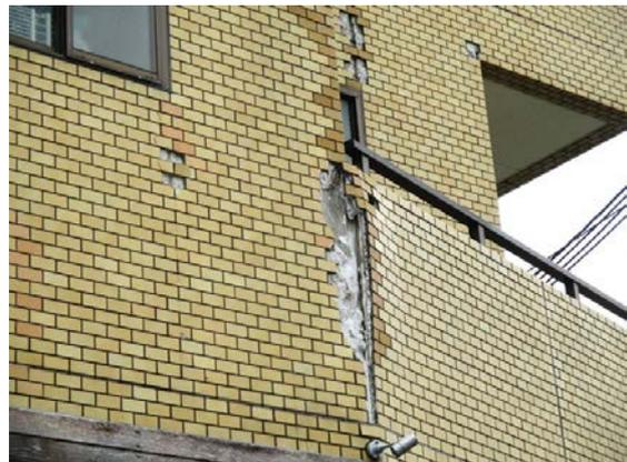
図 26 マンションの外壁タイルの被害
