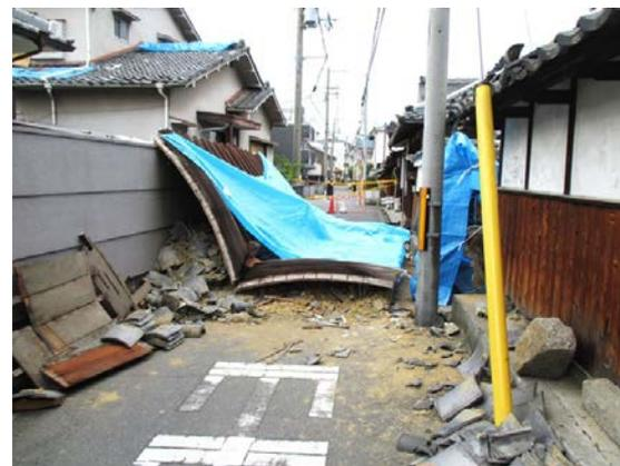
図 12 浄教寺山門の被害 (右の写真 12-2 は浄教寺南側の道を別角度から撮影)
