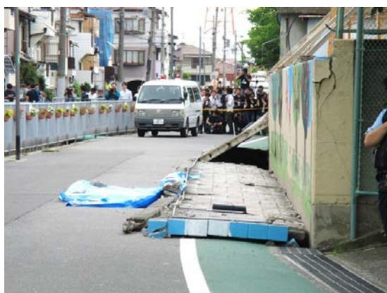
図20 寿栄小学校の倒壊したブロック塀
