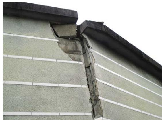
図 24 本照寺北東角の(ブロック)塀の被害
