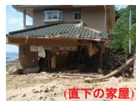
山頂近くから大量の土砂と立ち木が流れ下っているが、途中のアスレチック器具により一部の流化が留められ、コンクリート製の高床基礎を有していたので直下の管理棟は無被害であった。
