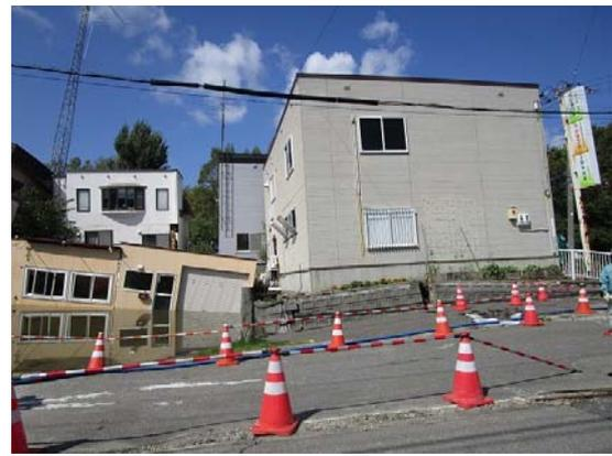
写真 2.1.4 G～H 地点：陥没の大きい場所での住宅被害
