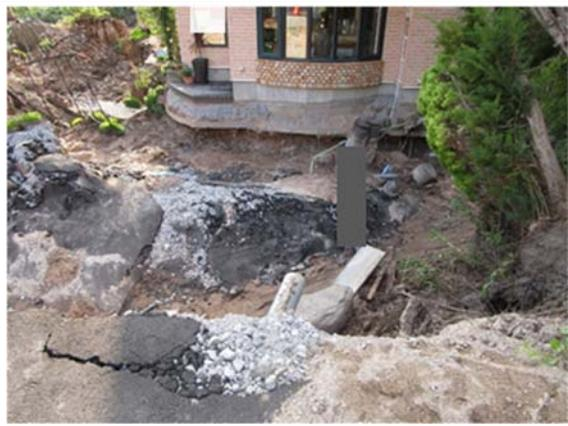
写真 2.2.2 前面道路側からの撮影（住宅の周辺または全面に地盤の崩落部分を確認される）
