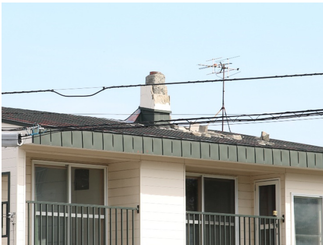
写真 52 煙突の被害（地点 k）
