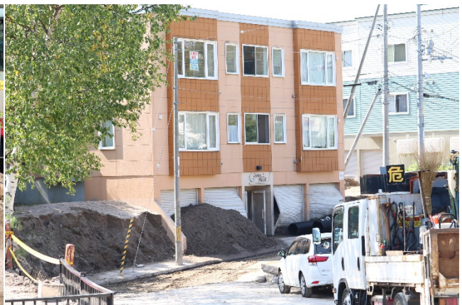
写真 41 液状化被害（地点 c）
