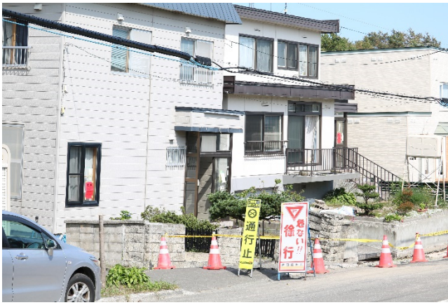
写真 44 液状化被害（地点 f）
