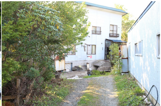
写真 63 地盤ごと移動した建物 (地点 c)
