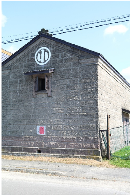
写真 27 組積造の被害
