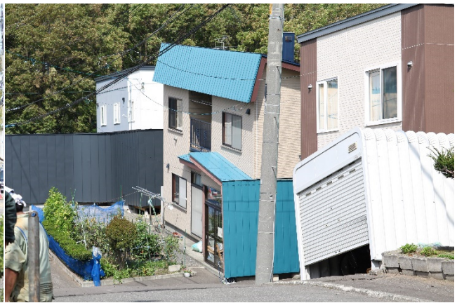
写真 47 液状化被害（地点 g）
