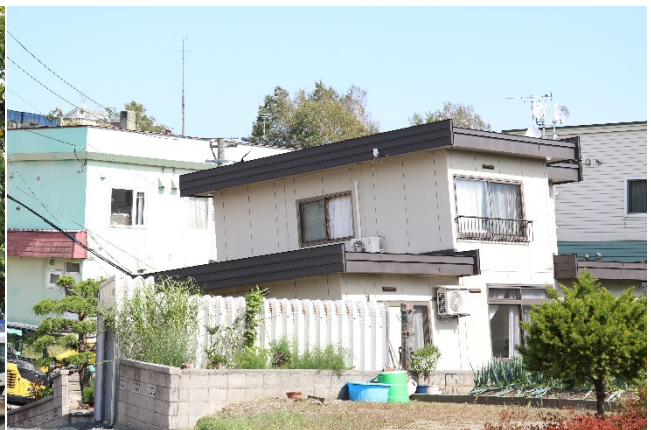
写真 43 液状化被害（地点 e）
