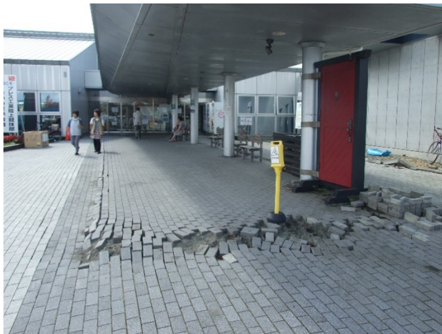
写真 1 舗装ブロックにずれ ((1)商業施設 A)
