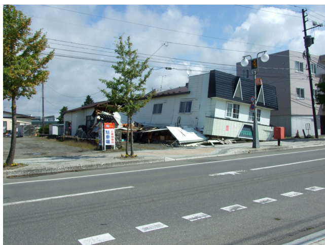
写真 7 木造店舗の倒壊
