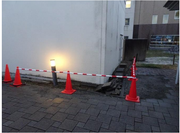
写真 17 旧棟周りの地盤変状
