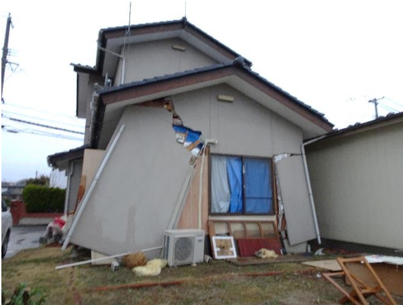
写真 25 外壁の損傷
