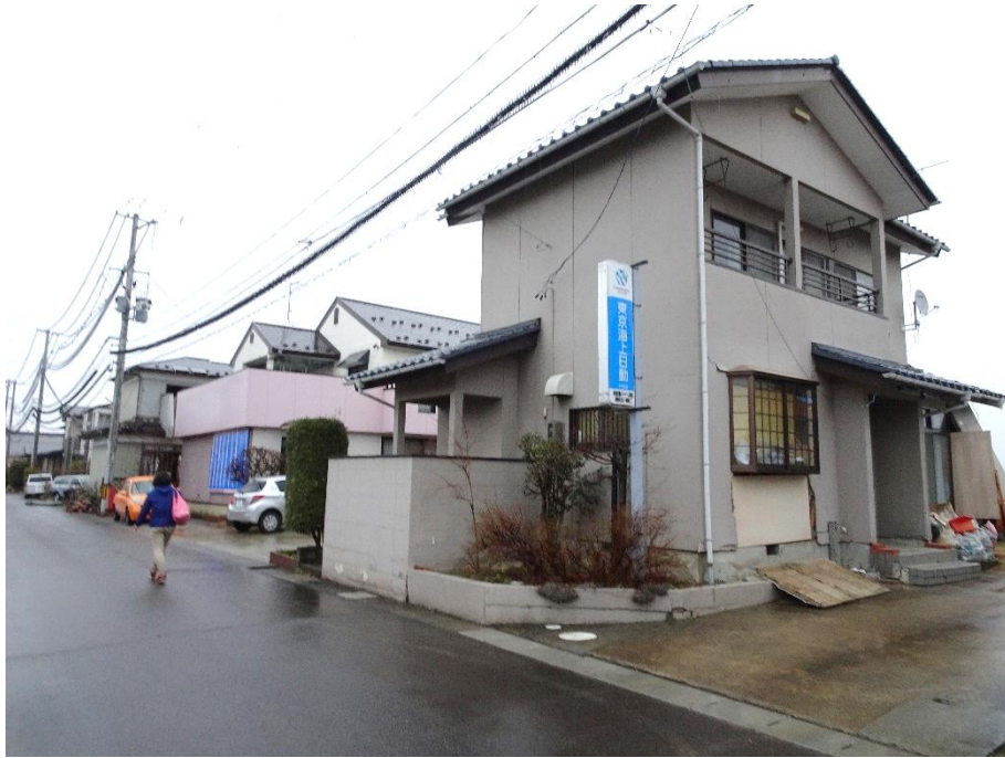
写真 24 被害の大きかった住宅 東日本大震災でもある程度被害を受けたがこれ程ではなかった
