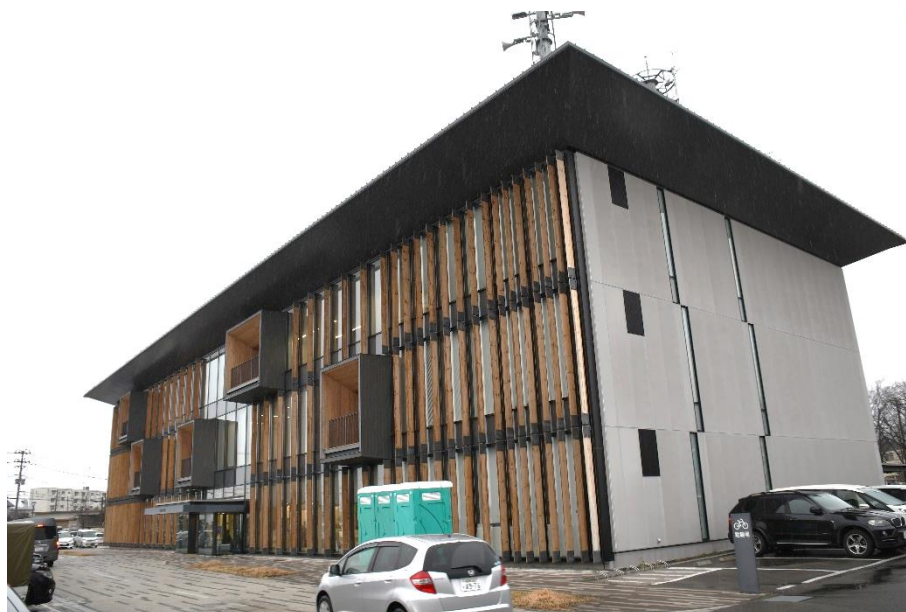
写真 10 国見町庁舎外観
