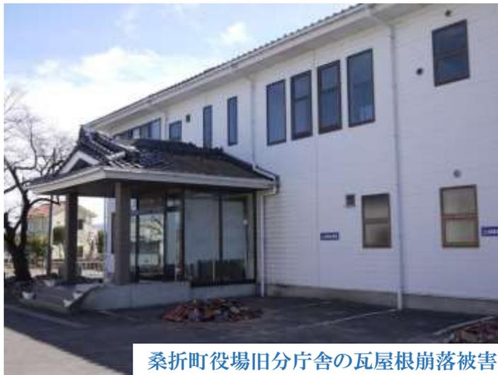
桑折町役場旧分庁舎の瓦屋根崩落被害
