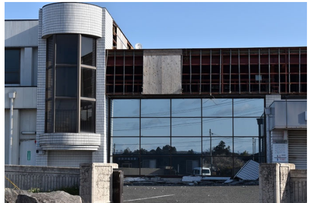
写真 2.2.7 外壁の剥落
