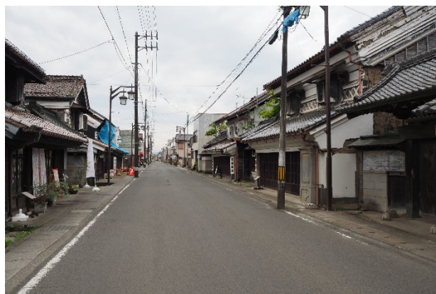
写真 3-1 店蔵の瓦屋根・土壁被害や表門の被害を受けた伝統的建造物群保存地区（村田町）
