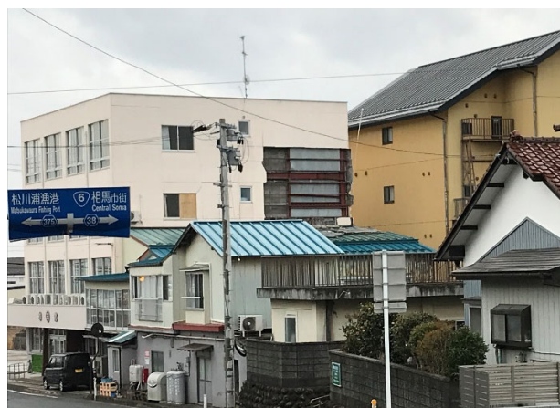
写真2.2 S造外装材の剥落
