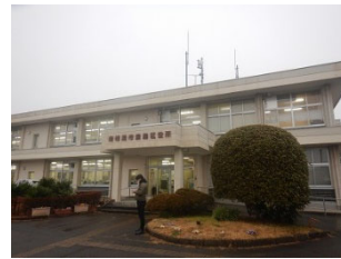
写真 31 南相馬市鹿島区役所
