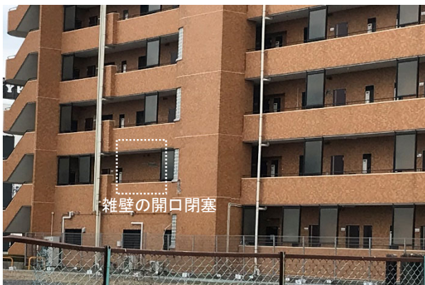
写真 7.1 復旧後に再び被災した集合住宅雑壁の損傷① — (左: 2022 年の損傷状況であり 2021 年からの復旧に際して雑壁を減らしている、右: 2021 年における同一箇所の損傷を記録したもの)
