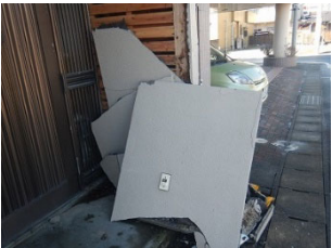
写真 23 外壁の被害
