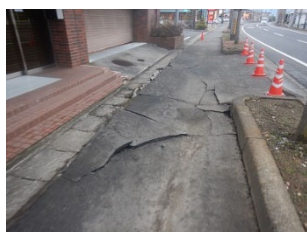
写真6 舗装の被害
