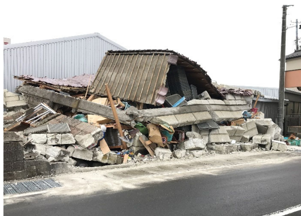
写真2.1 組積造の崩壊（市街地より東、沿岸部）
