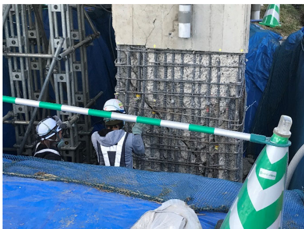
写真 3.3 高架橋柱脚のはつり作業（写真 3.1 右下の柱脚を撮影したもの。主筋の座屈を確認）
