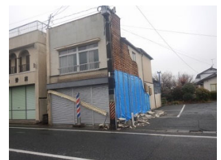
写真 34 外壁の被害
