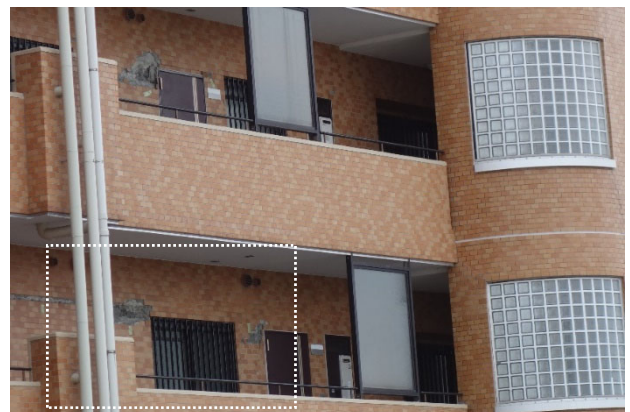
写真 7.1 復旧後に再び被災した集合住宅雑壁の損傷① — (左: 2022 年の損傷状況であり 2021 年からの復旧に際して雑壁を減らしている、右: 2021 年における同一箇所の損傷を記録したもの)
