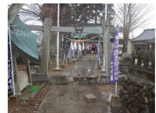
写真 36 鳥居の被害
