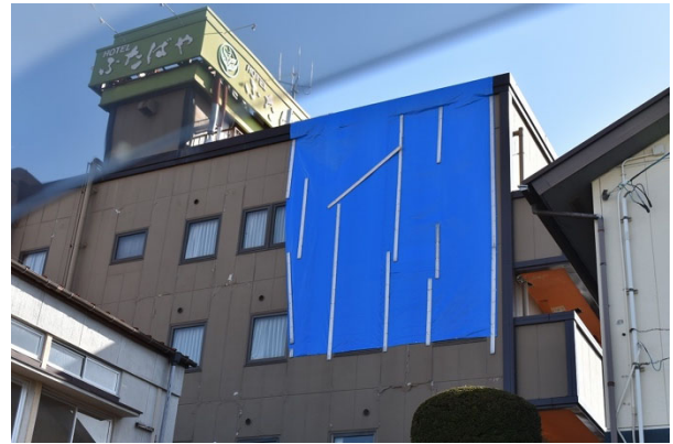
写真 2.2.8 外壁の剥落
