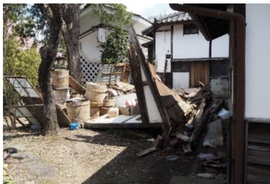
写真 4-3 雪害で半壊状態だった小屋の倒壊
