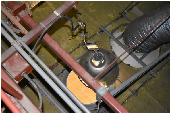
写真 2.2.4 アリーナ天井裏詳細
