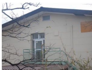
写真11 外壁の被害
