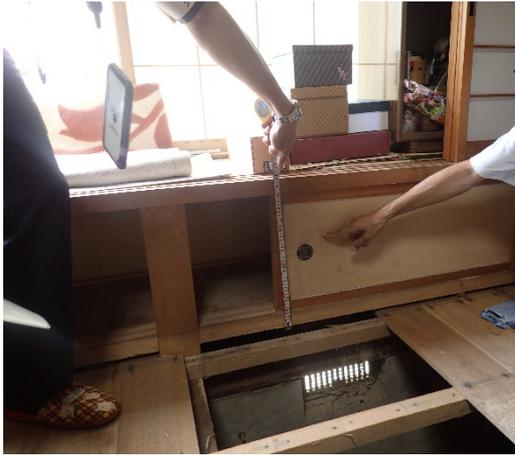
床上の浸水痕と床下換気口
