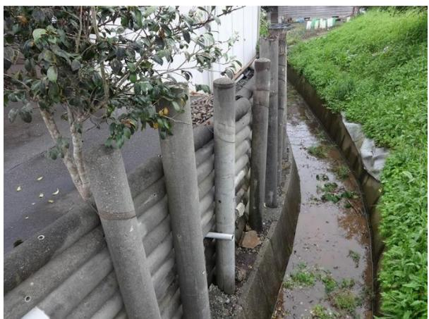
⑥蛸島町：電柱と杭で作成した擁壁（地盤変状の程度は不明）
