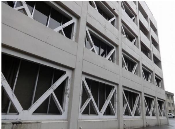
珠洲市役所（鉄骨ブレースによる耐震補強が施されている）
