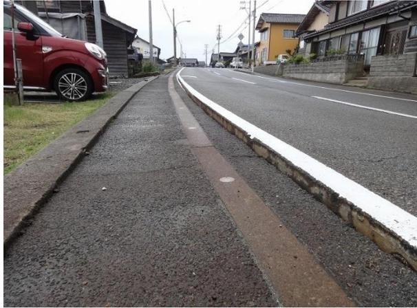
⑥ 道路の歩道部分の沈下（沈下したのは海側）
