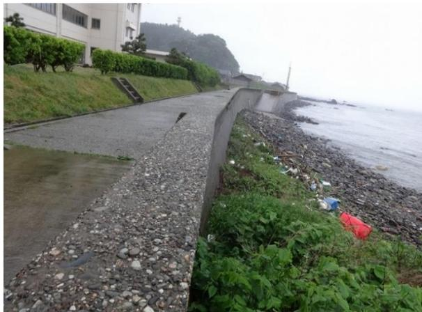
観測点から護岸までの距離は約 15 m。護岸の高さは 3 m 程度。
