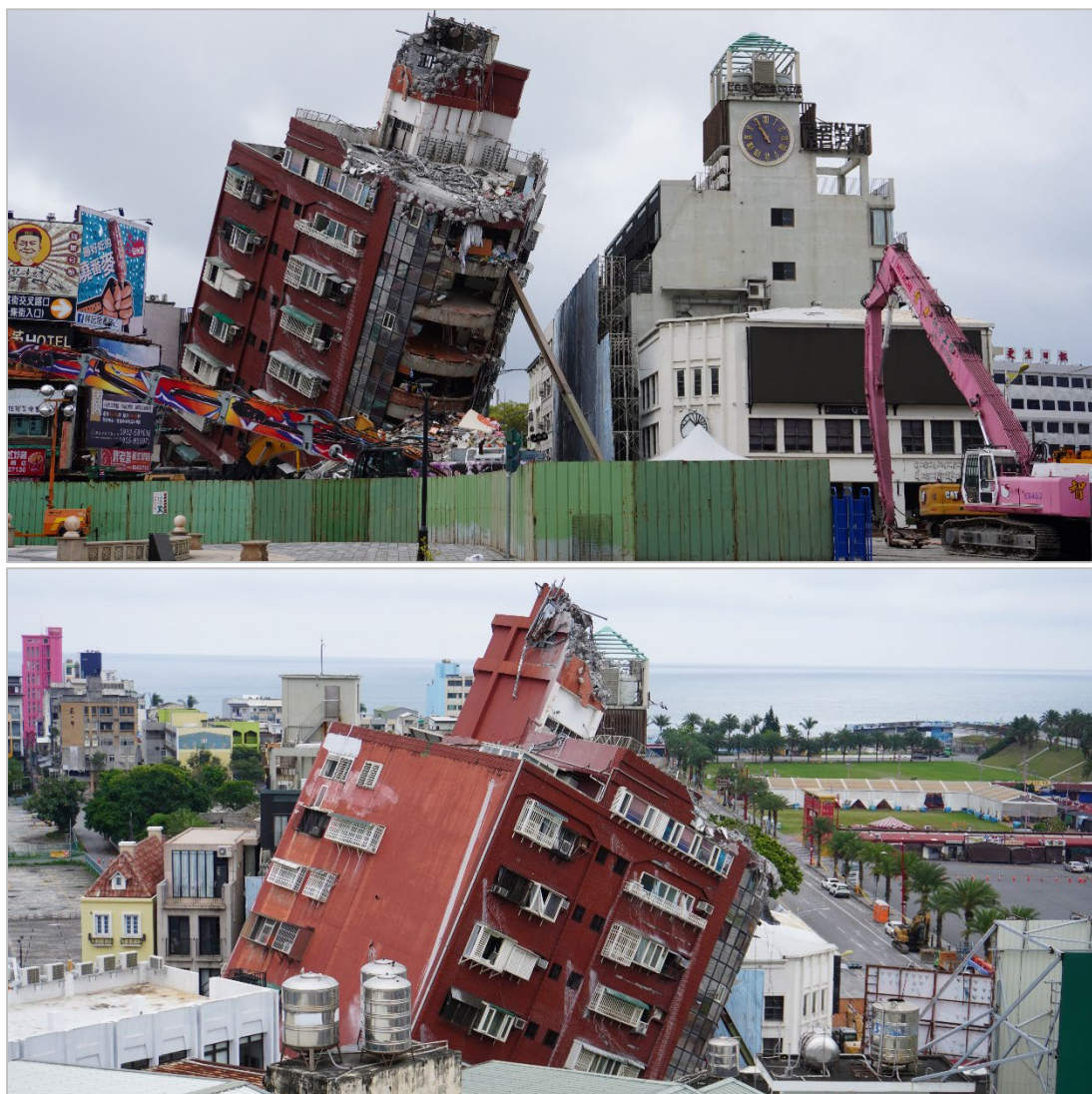
Figure 8 H3 全景(上：南西から，下：北西から)
