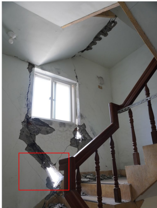
階段室の被害(1階→2階)
