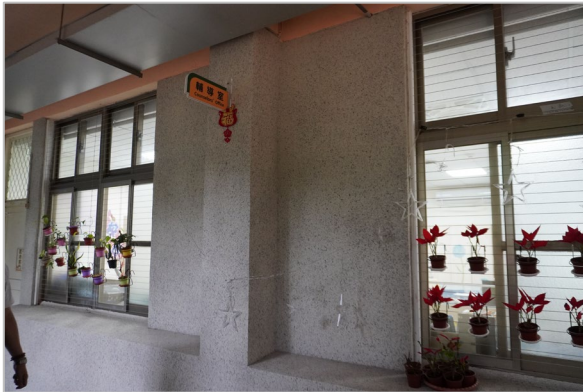
校舎 2: 増設袖壁(横幅 900mm)
