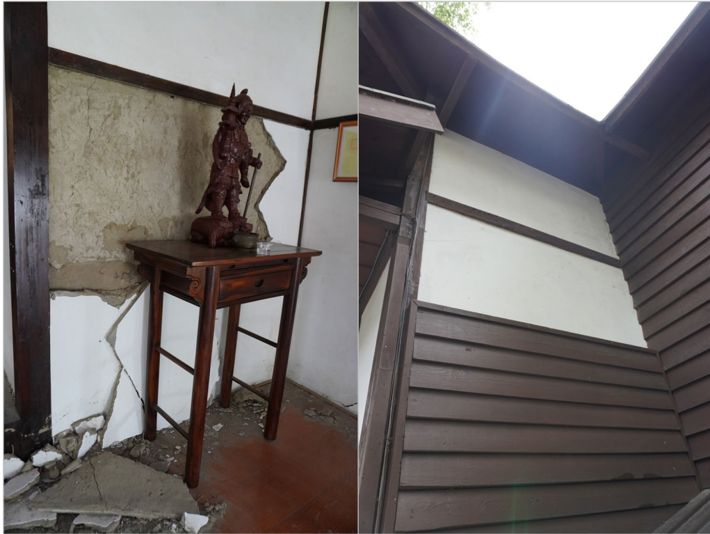
土壁のせん断破壊(左:中から, 右:外から) Figure 49 J4 本殿の被害
