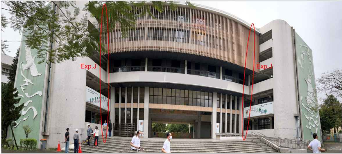
校舎 1 全景 (西より)
