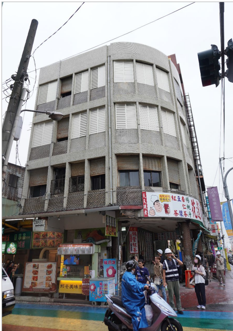
Figure 25 建物 H14 全景(南東より)
