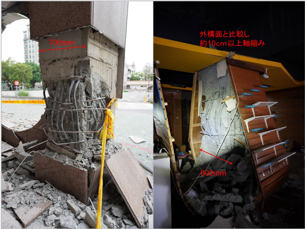
柱の損傷
