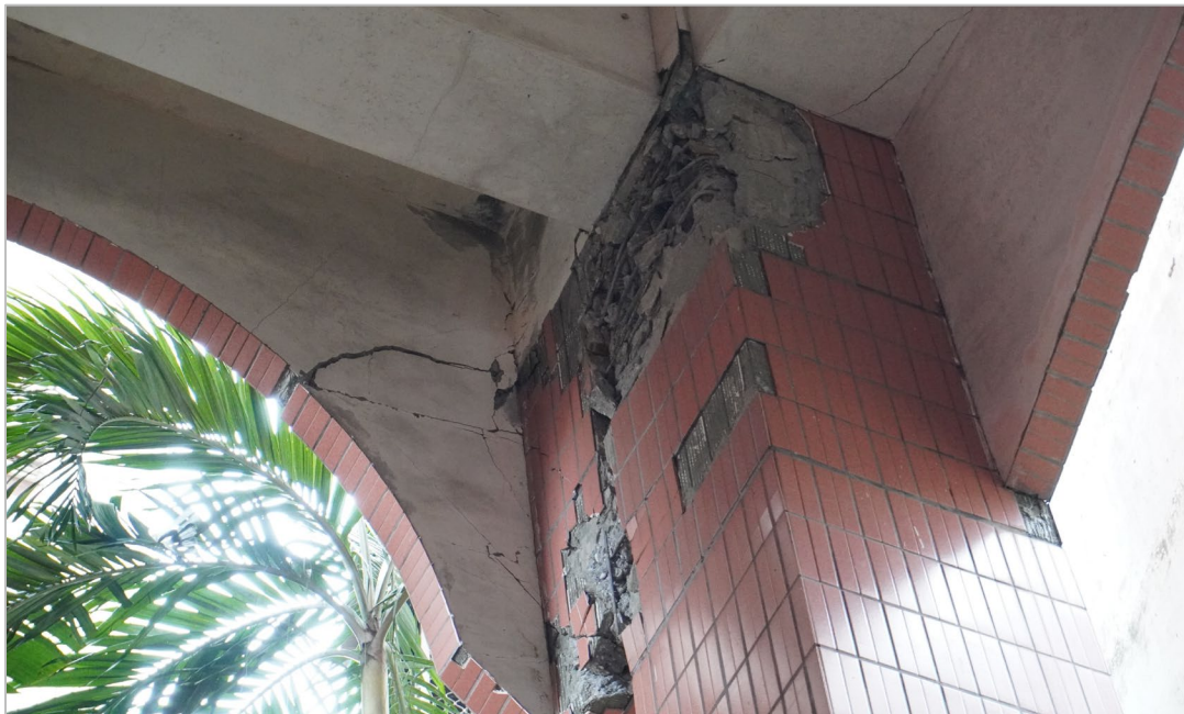
柱頭の損傷
