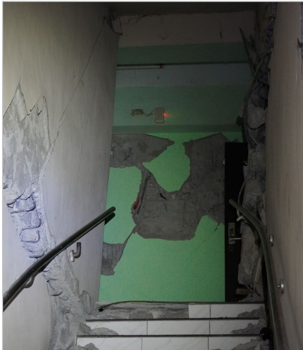
室内 RC 壁の破壊
