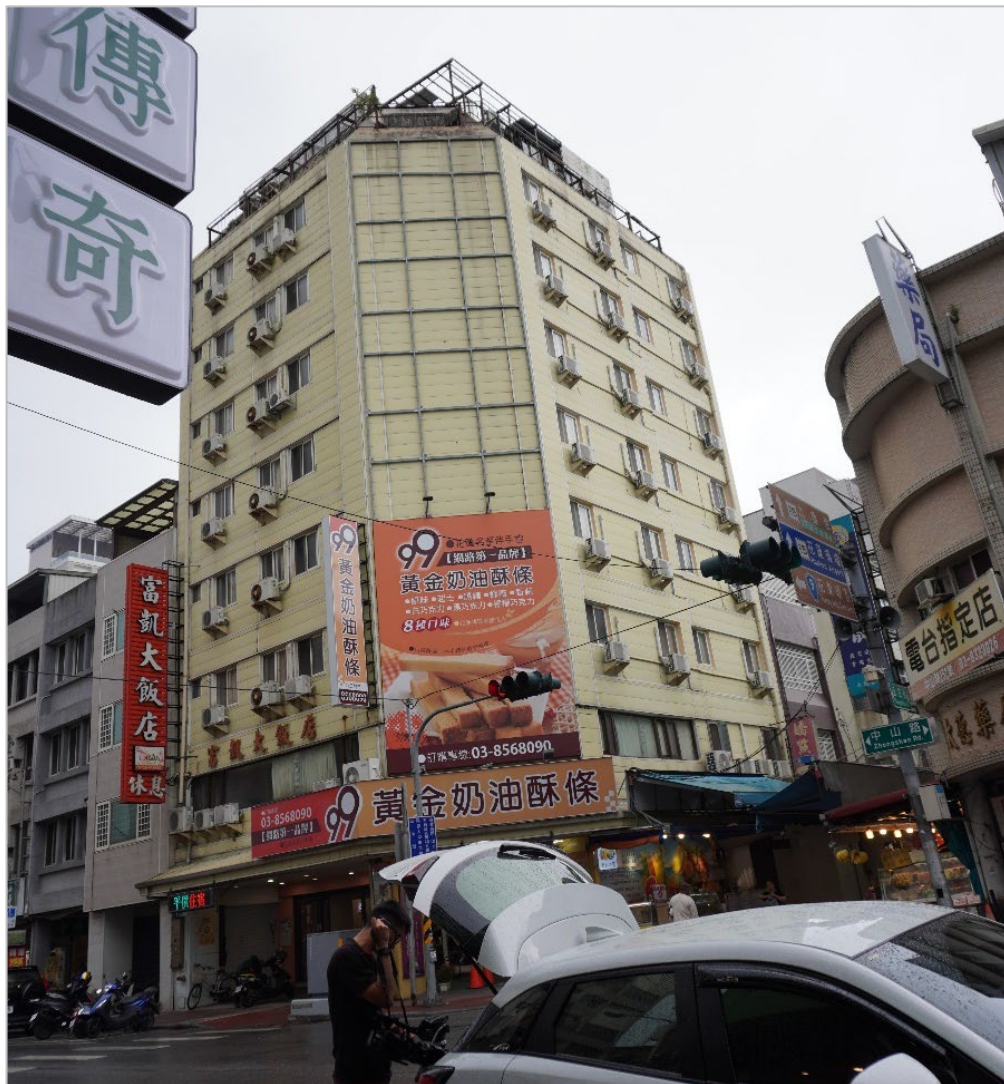
Figure 27 建物 H15 全景(南より)
