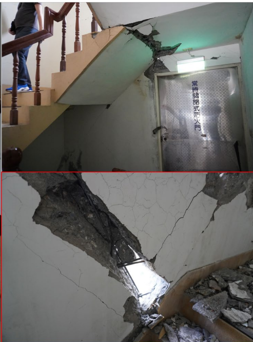
階段室の被害(1階→2階)
