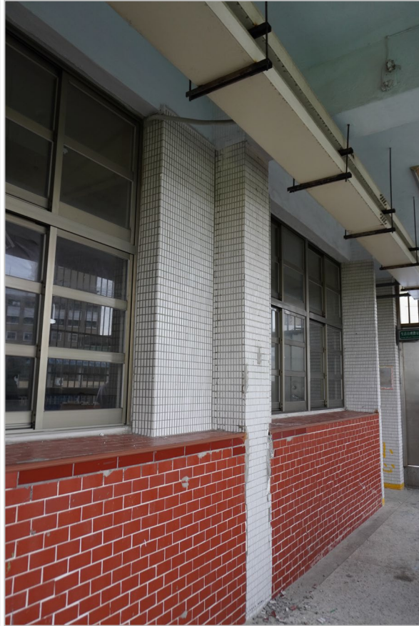
校舎 3: 袖壁増設による耐震補強(桁行のみ)
