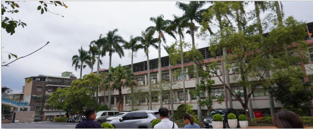
校舎 1 全景(北西より)
