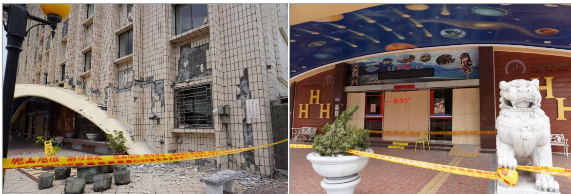
Figure 7 H2 の被害状況
