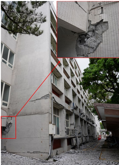
建物外観(東側から)
