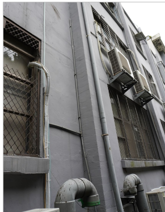
左写真の柱を外から(ひび割れは確認できず)
