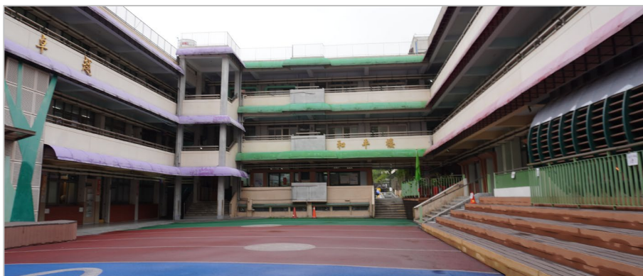
校舎 2 全景(西より)
