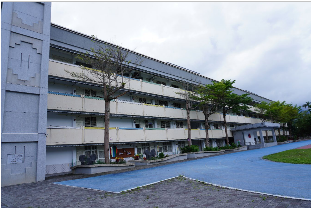
Figure 34 建物 H20 全景(北より)
