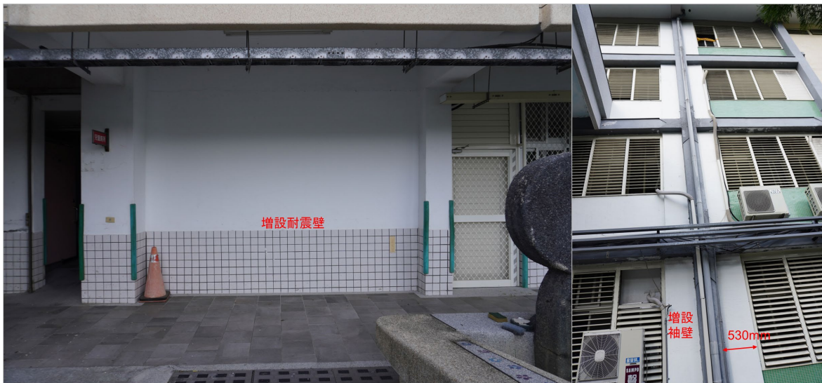
Figure 36 建物 H20 の耐震補強
