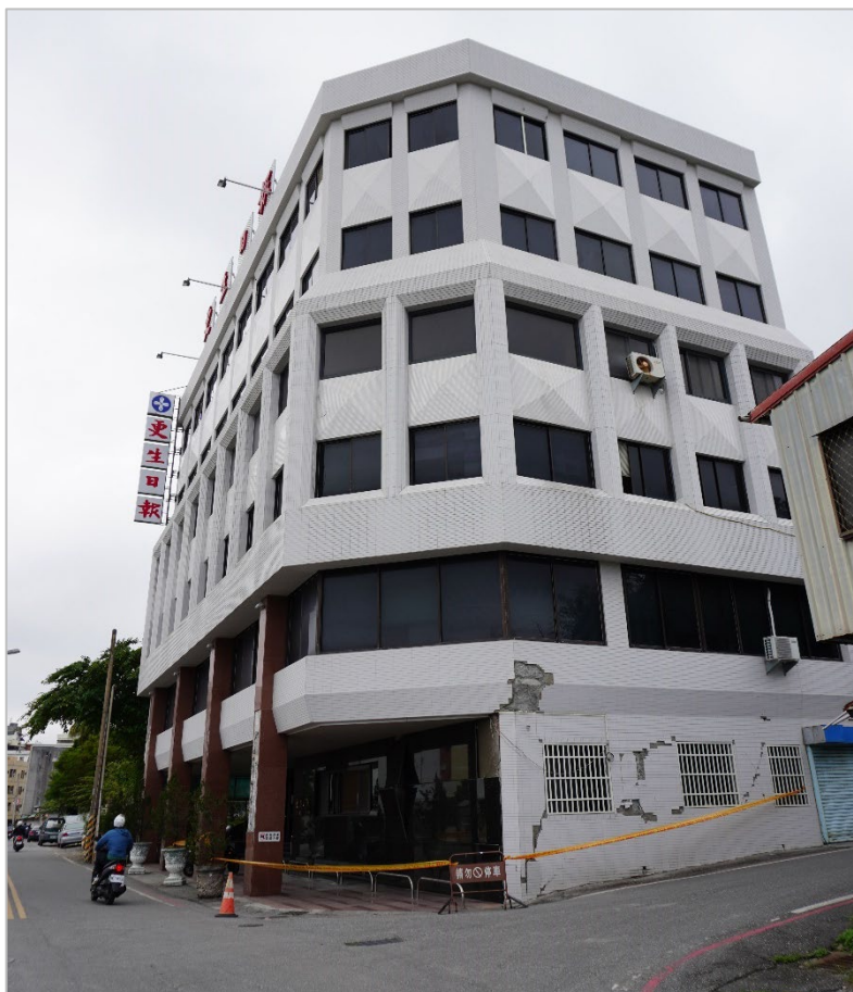
Figure 16 建物 H8 全景(南東より)
