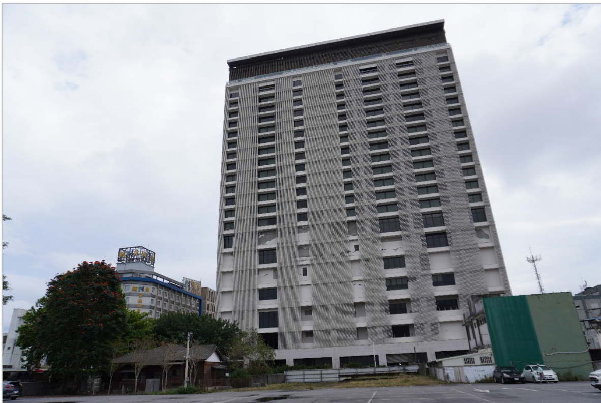
Figure 31 建物 H18 全景(北西より)
