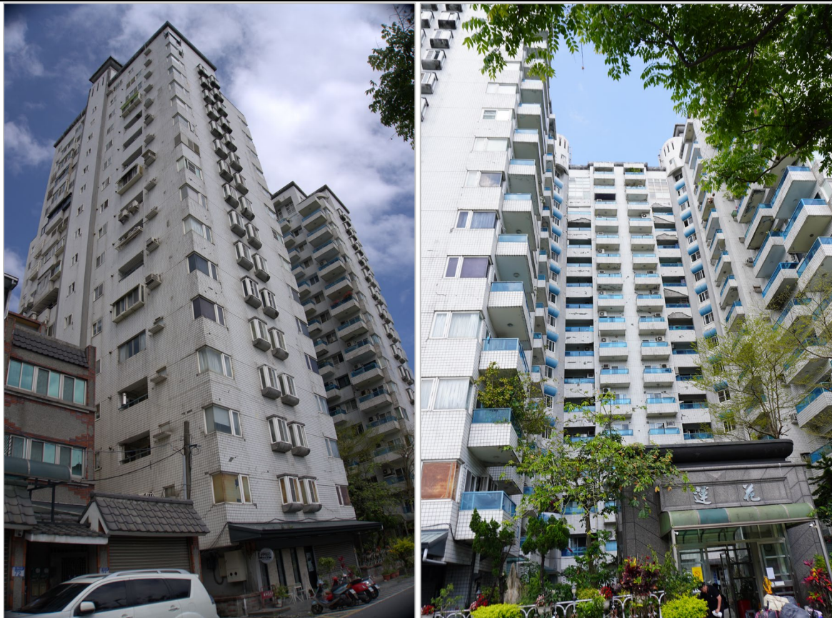
Figure 54 建物 J6 全景(左:西より, 右:正面(南西)より)
