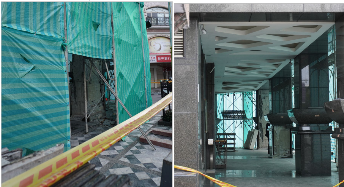
Figure 33 H19 の被害状況
