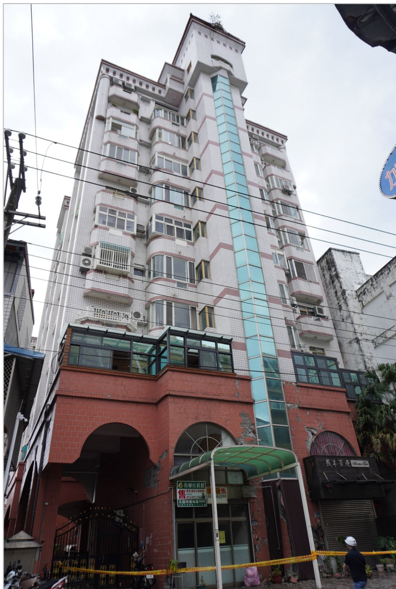
Figure 40 建物 J1 全景(南西より)
