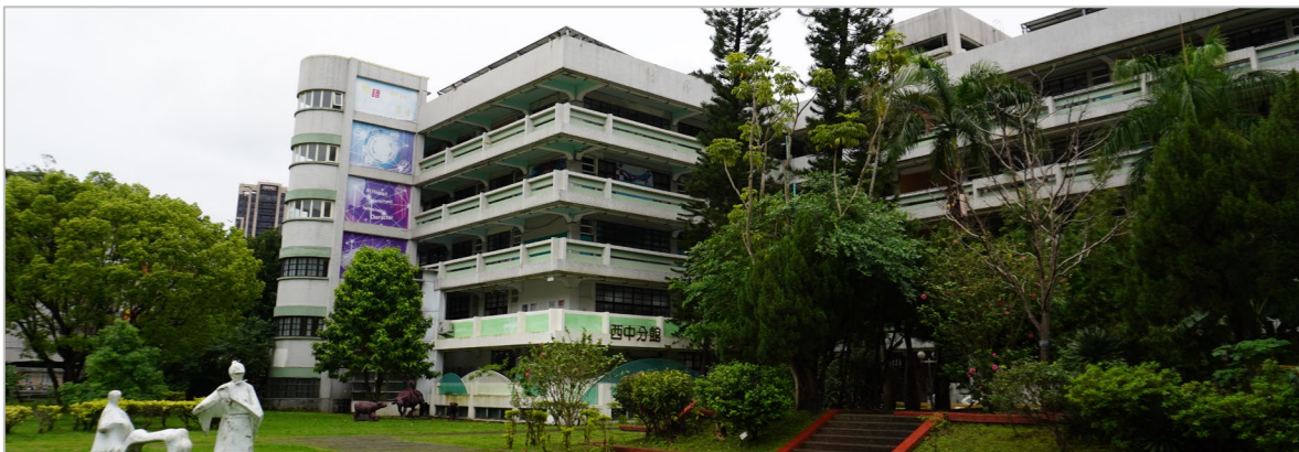
校舎 3 全景 (北西より)
