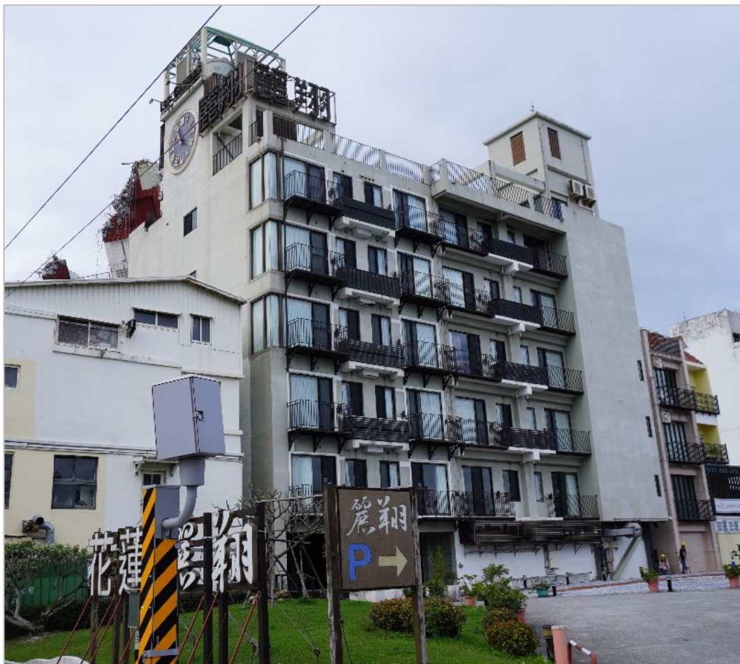
Figure 28 建物 H16 全景 (南より)
