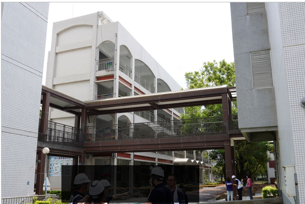
Figure 4 H1 全景 (西側から)
