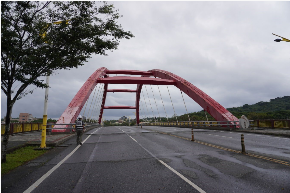
Figure 29 橋梁 H17 全景(西側)
