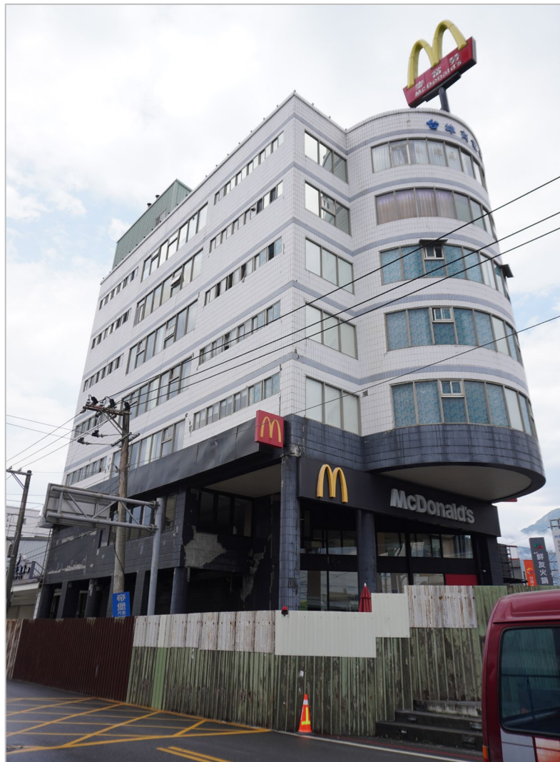
Figure 42 建物 J2 全景(東から)
