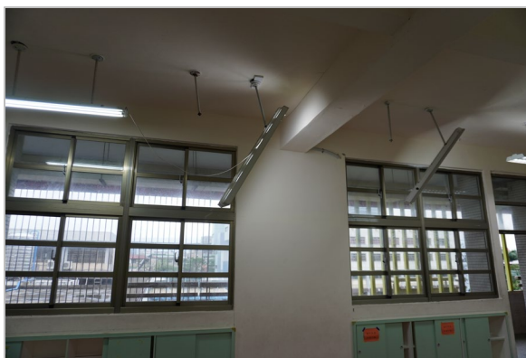
校舎 3:袖壁増設補強された柱
