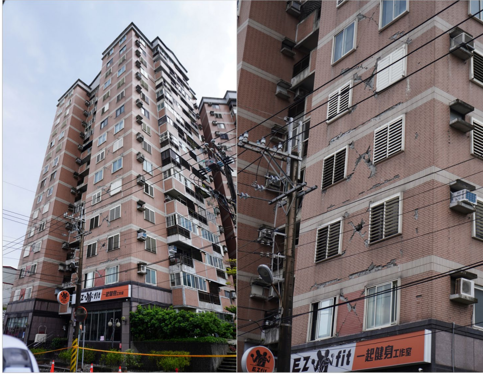
方立壁のせん断破壊(北棟の北側構面)
