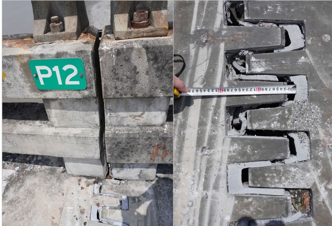
P12(P13の西側の柱位置)でも同様の変位
