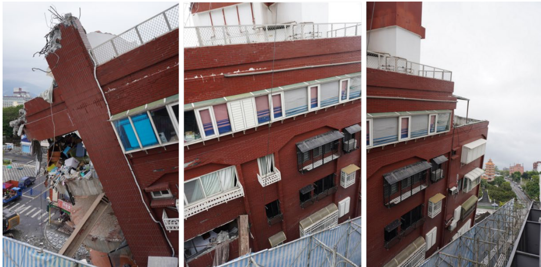
上層外周に目立った構造被害は見られなかった
