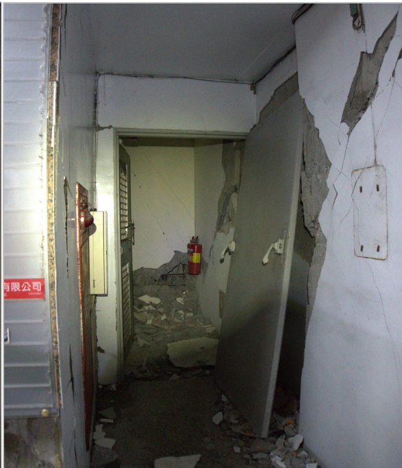
室内 RC 壁の破壊
