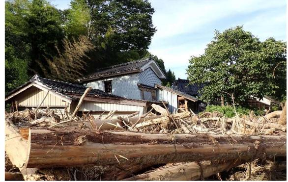
竹中川の氾濫後(左)と流木・泥流による家屋被害(右:地震被害も受けていた)
