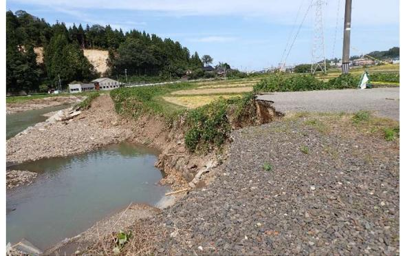
横地町姫田橋の落橋と河岸浸食による被害
