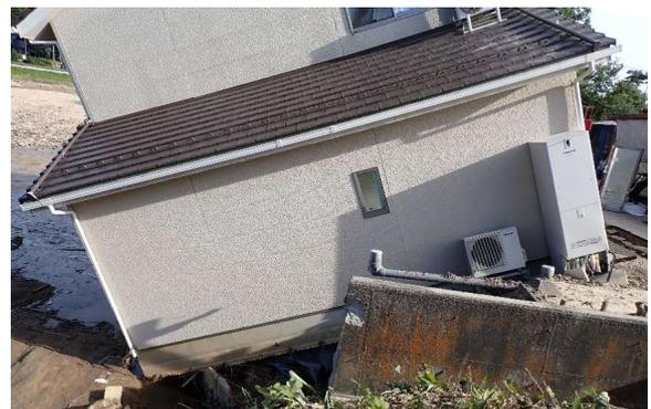
河岸浸食で傾斜した2000年基準の木造住宅(躯体に歪みはあるが基礎はほぼ無被害)
