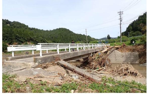
西脇町猪平橋の流木による被害(盛土部の沈下は震災と思われる)
