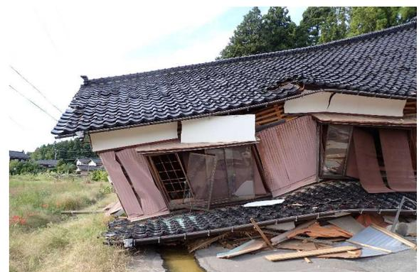
斜面崩壊で倒壊した古い家屋(1階が崩壊)
