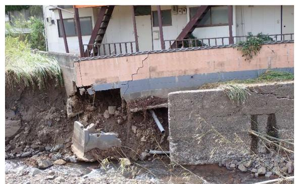
堂山(下流側)の流木閉塞による迂回流と河岸浸食による長屋建物の被害
