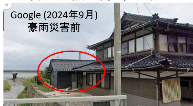
上写真の建物の川を挟んだ向かいの 豪雨災害前の古い木造住宅
