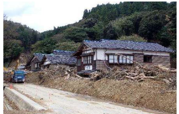
土石流で3m程度の土砂・流木が堆積 道路の土砂を撤去中だが、1階は埋没
