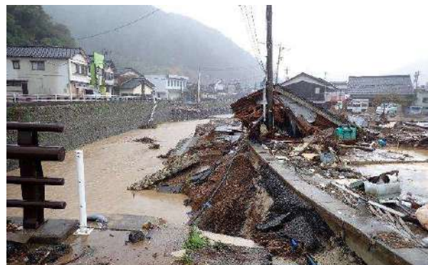
地震で被災した木造建物が、洪水と河川浸食でさらに被害を受けてた
