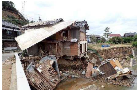
河川浸食と洪水により部分崩落した 左写真の建物
