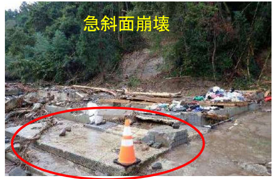
急斜面崩壊 流失した家屋と裏山の急斜面崩壊 (赤丸は左写真のアプローチ・玄関部)
