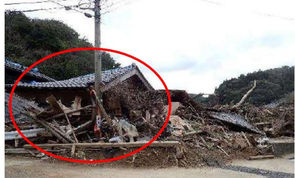
左写真の赤丸の流失家屋は手前橋で堆積。青丸の倉庫は完全崩壊と推定
