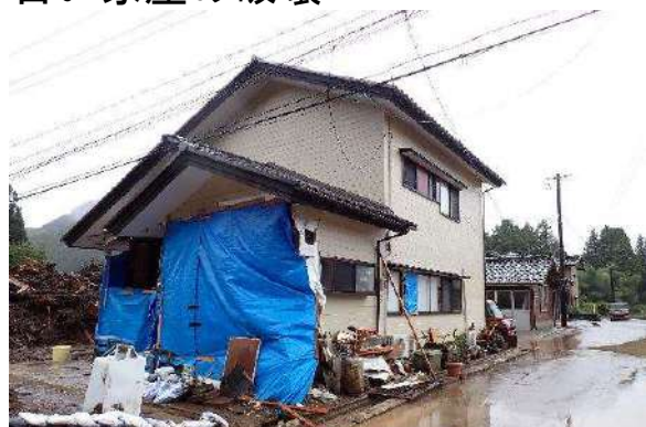
土砂と流木による古い建物の被害
