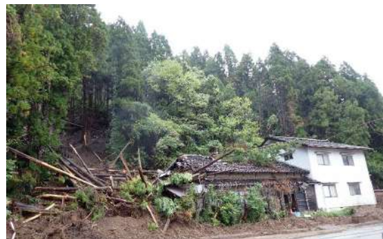
がけ崩れによる土砂と流木による 古い家屋の破壊
