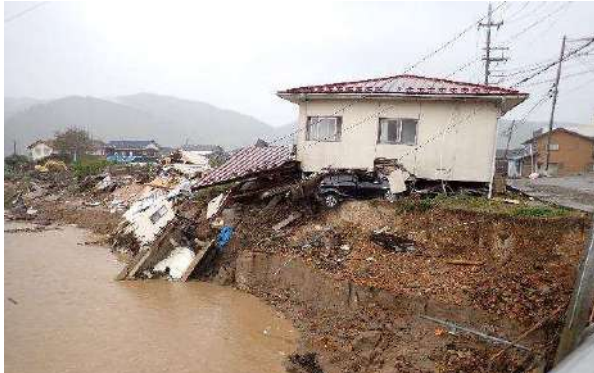
能登半島地震で1階が崩壊した古い木造敷地地盤が大きく河川浸食されている
