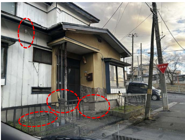
No.25 : 基礎破損、ひび割れ、剥離・剥落
