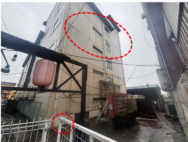
No.14：ひび割れ、基礎破損
