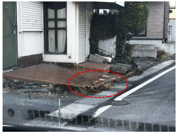
No.22 ( 長根 ): 基礎破損
