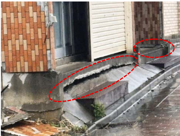
No.7：基礎破損、ひび割れ、剥離・剥落
