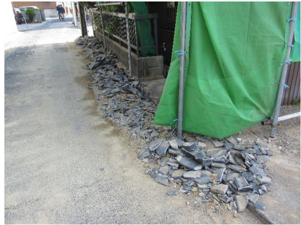
炬口地域の民家の被害（瓦の剥落）
