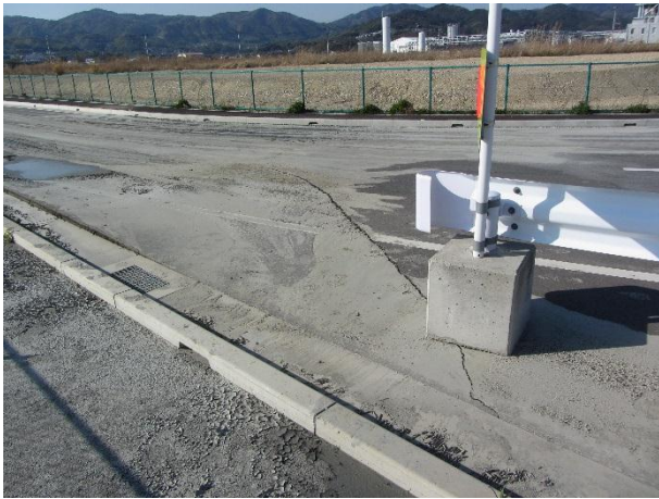
メガソーラー施設付近の液状化被害
