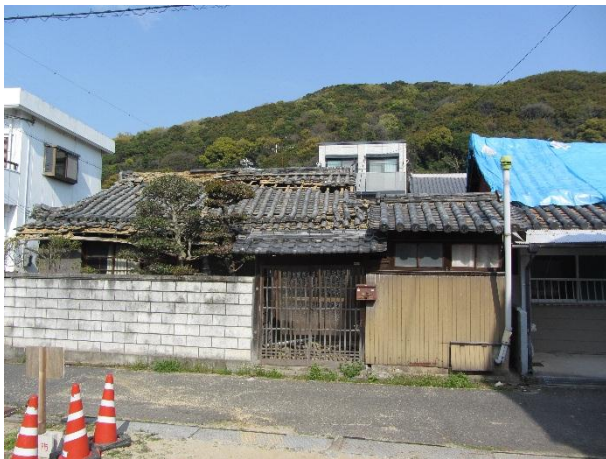
炬口地域の民家の被害（瓦の剥落）
