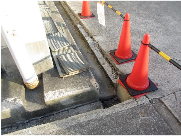
側溝の被害その2
