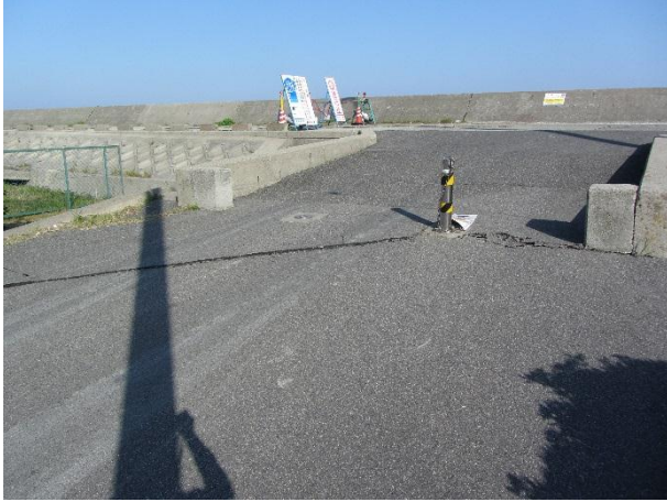
駐車場から堤防へ渡る石橋 B
