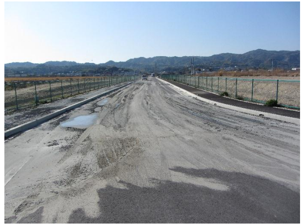
メガソーラー施設付近の液状化被害
