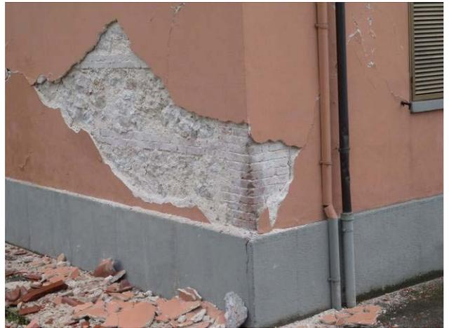
写真 19 建物⑥：柱は煉瓦、壁は石積で約 50cm ごとにレベルをとるためのレンガを挿んでいる
