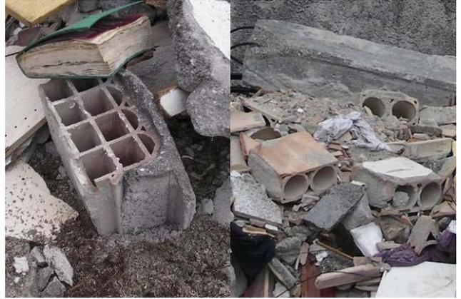
写真2 建物①：空洞煉瓦
