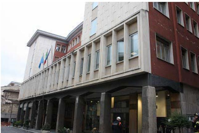
写真5 1階部分がピロティ形式の建物(2)
