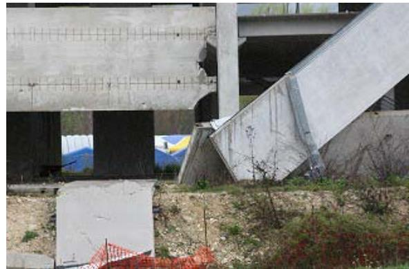
写真11 PC 外壁と床版の崩壊
