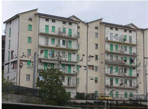
写真 15 建物⑤：3階、4階での被害が目立つ
