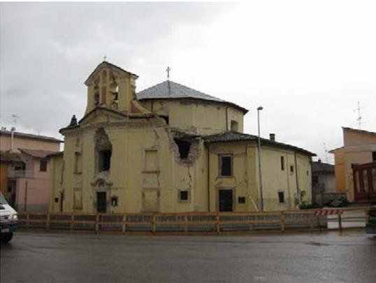
写真 14 教会の組積壁の崩落
