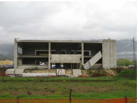
写真10 建設中の PCa 造工場の被害
