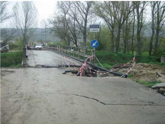
写真8 Onna へ渡るの橋の接続道路の崩落
